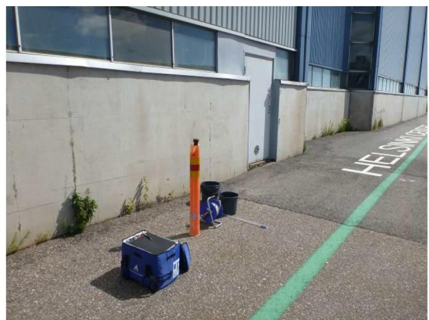
Valokuva 6. Pohjavesiputki HP325
