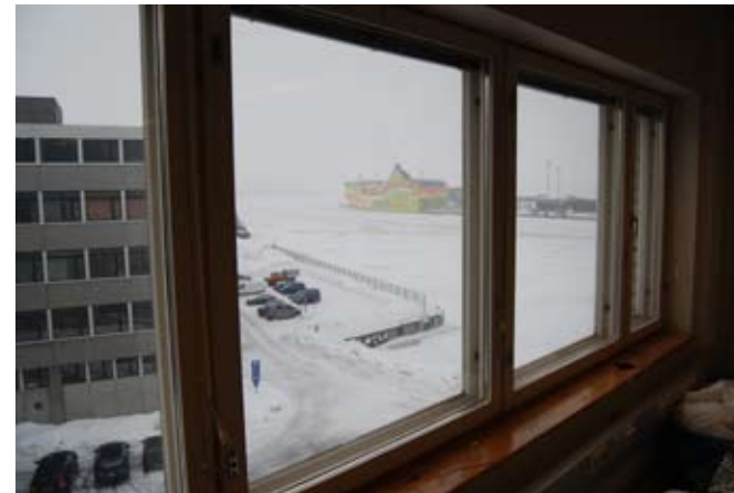
Kuva 6.98 Tasovaraston etelän puoleisessa päädyssä ikkunoissa on erilainen puitejako kuin pitkällä sivulla.
