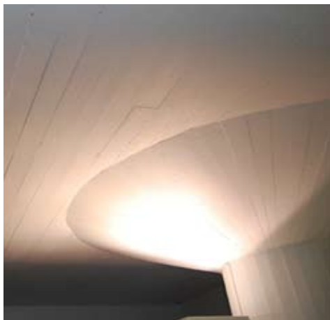
Kuva 6.96 (vasemmalla) Tasovaraston sienipilari ja lauta-muottiin valettua välipohjaa 4. kerroksen toimistotilassa (MTG Meltron).
