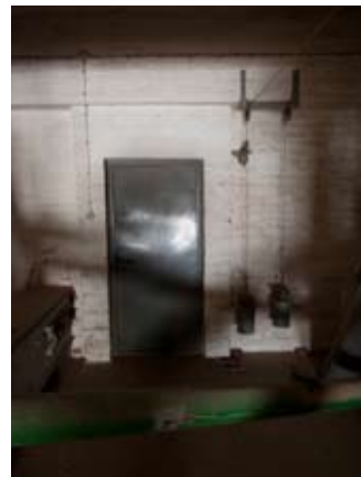
Kuvat 6.58-6.60 (alla) Ikkuna ja koneiden asennusaukko. Tilan ovi on rakennukselle tyypillinen maalattu teräsovi (1950-I tyyppi) Viljanjakaja tilan takaosassa. Valokuvat Talli / MN.
