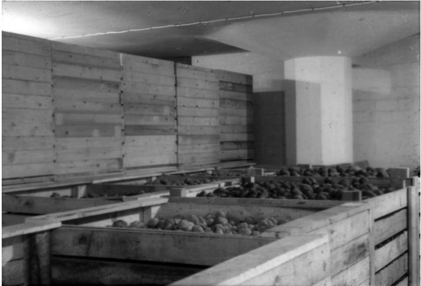
Kuva 4.23 Perunoiden varastointia laareissa Munkkisaaren varaston kellariker- roksessa. Kuvassa näkyvät kellarin kulmikkaat sienipilarit. SVA
