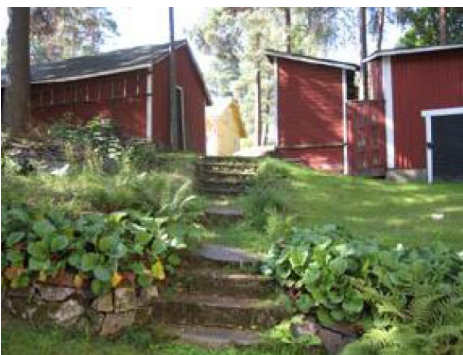
GRANELUND, TALOUSRAKENNUKSET, 2 KPL HEIKINNIEMENTIE 1
