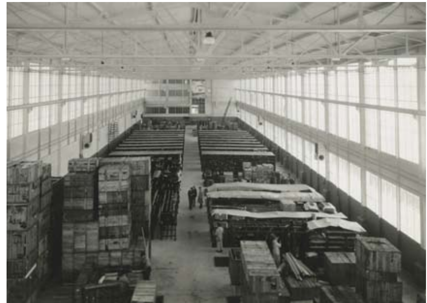
Kuva 1.3 Tukholman Frihamnin Fordin tehtaan sisätila vuonna 1930. Lähde http://commons.wikimedia.org/wiki/Category:Fordbyggnaden_Stockholms_frihamn
