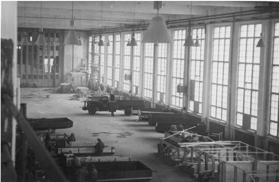
Kuva 3.12 Näkymä parvelta kokoonpanohalliin, kohti pääportaan ikkunaseinää. MOBA.
