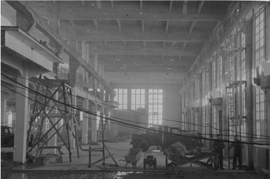
Kuva 3.10 Nosturihalli rakennustöiden aikana, näkymä kohti hallin eteläpäätä. MOBA.
