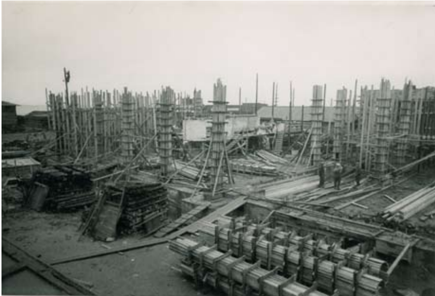
Kuva 3.5 Rakennuksen runkotyöt käynnissä, kuvassa betonipilareiden muotteja. MOBA
