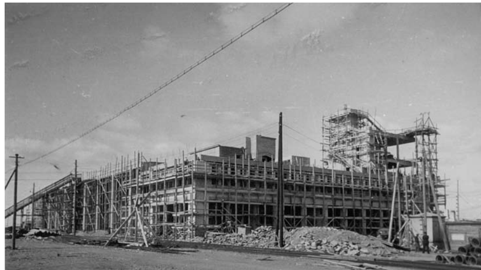
Kuva 3.8 Tehtaan työmaa. Torni nousee. FORD
