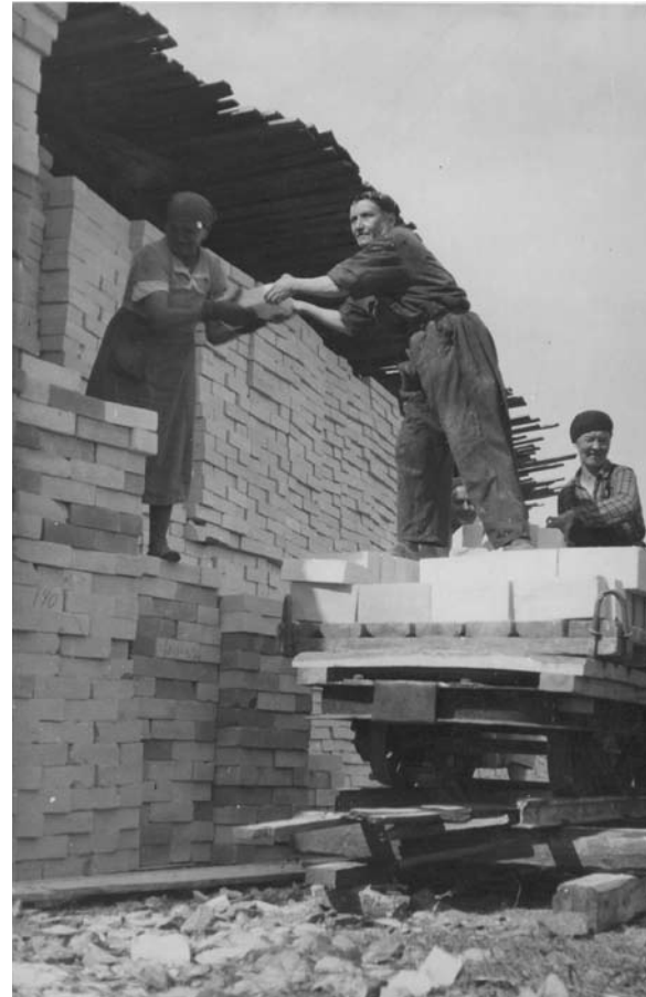
Kuva 2.5 Kalkkihiekkatiilien lastausta Fordin tehtaan työmaalla Hernesaarella. MOBA
