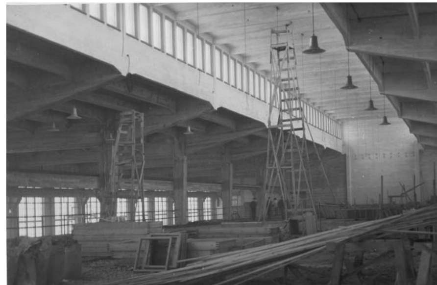
Kuva 3.13 Tehdashallin kattolyhty rakennustöiden loppuvaiheessa. MOBA.
