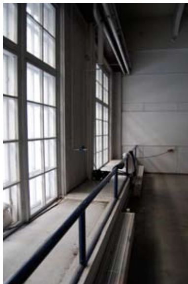
Kuvat 6.234-6.235 (ylärivi) Näkymä tilaan 221.1. Ikkunaseinän ja väli- pohjan liittyminen toisiinsa. Kuvat 6.236-6.237 Yleisnäkymä ja yksityiskohta tilasta 221.2
