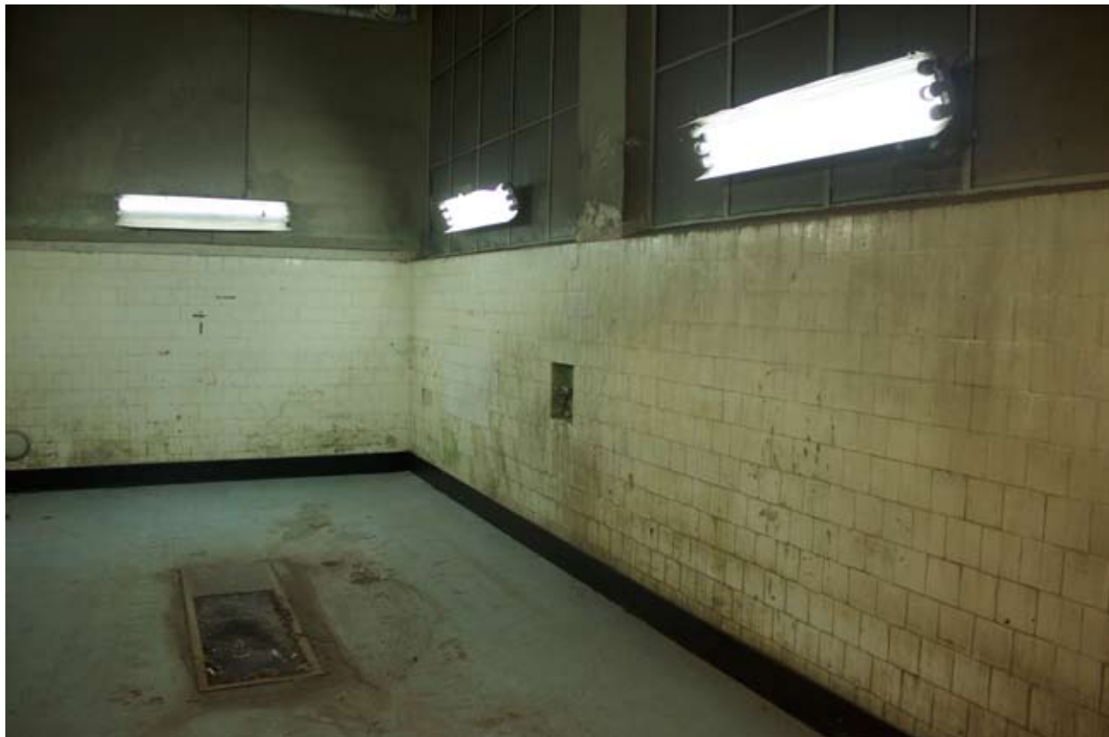
Kuvat 6.182-6.183 Näkymät autojen voitelutilaan "Smörjningsbox" 105.4
