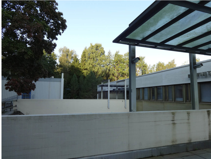
Yläkuvat: näkymä yhdyssillalta kohti Roihuvuorentietä (vasemmalla väistötilaparakit)
