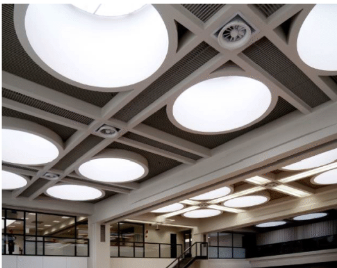
Kirjapanosali kattoikkuna- ja palkkirakenteineen
