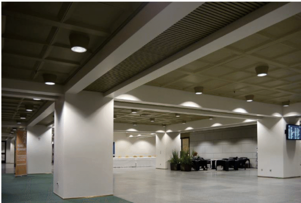
1. kerroksen sisääntuloaula / katon kaksoisprimääripalkisto
