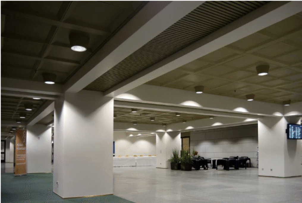
1. kerroksen sisääntuloaula / katon kaksoisprimääripalkisto
