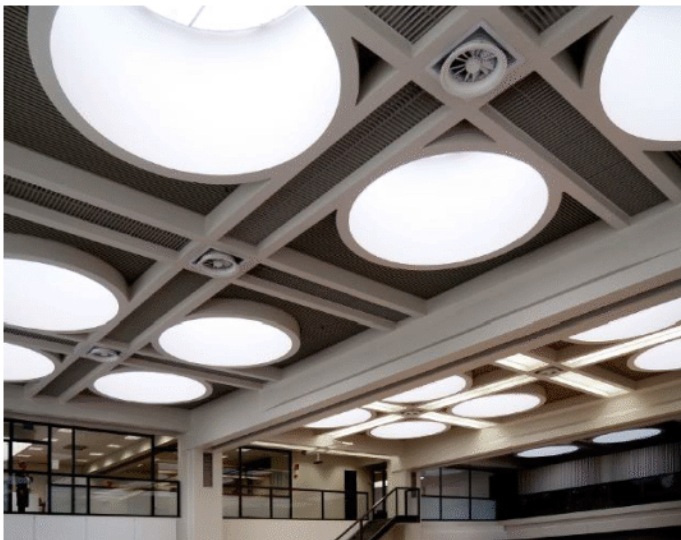
Kirjapanosali kattoikkuna- ja palkkirakenteineen
