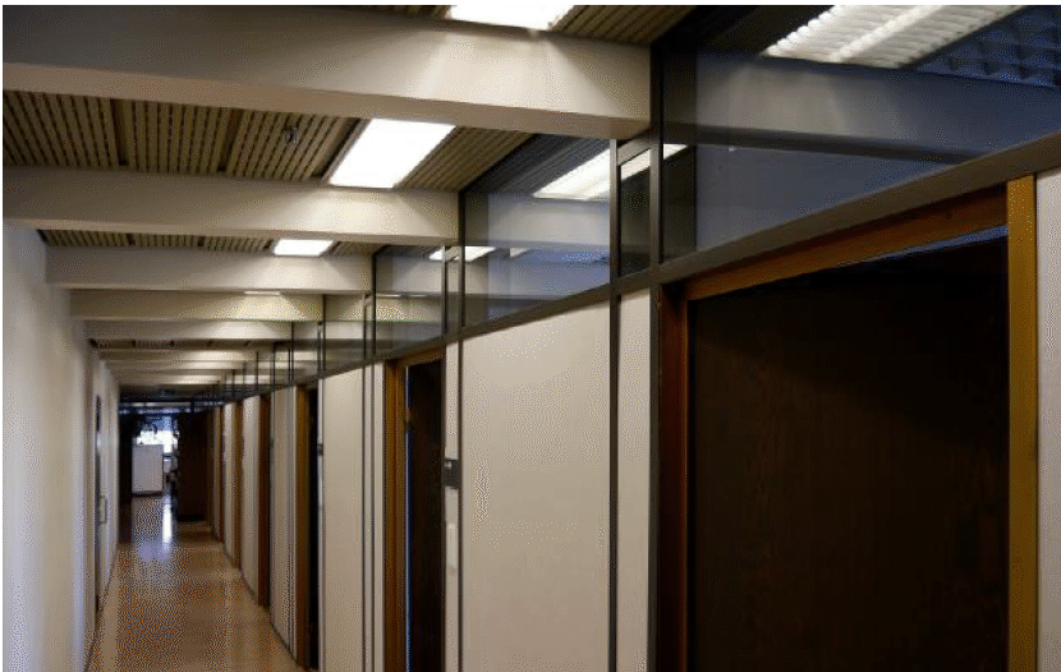
Toimistotilojen sekundääripalkkirakenteet
