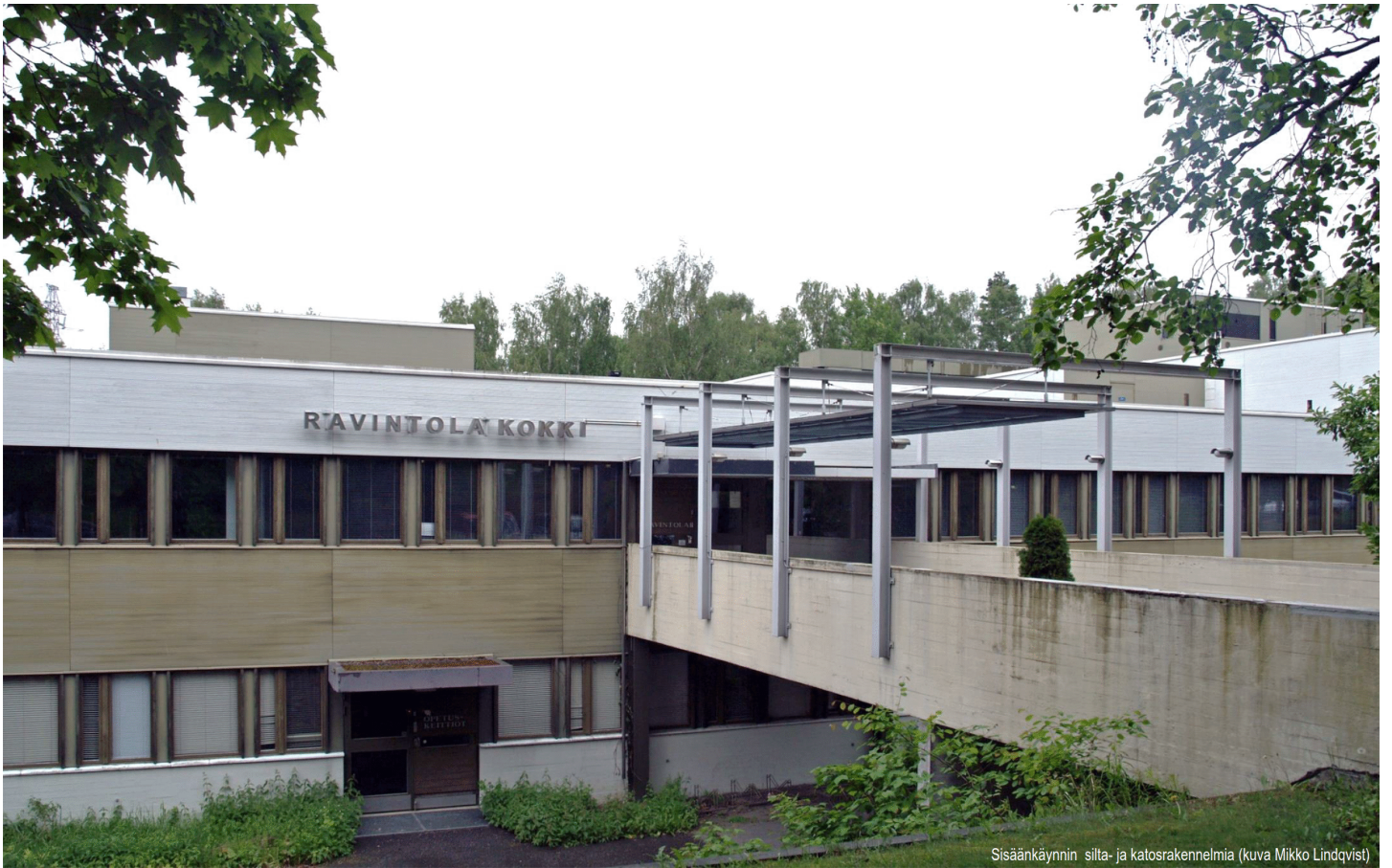
Sisäänkäynnin silta- ja katosrakennelmaa (kuva Mikko Lindqvist)
