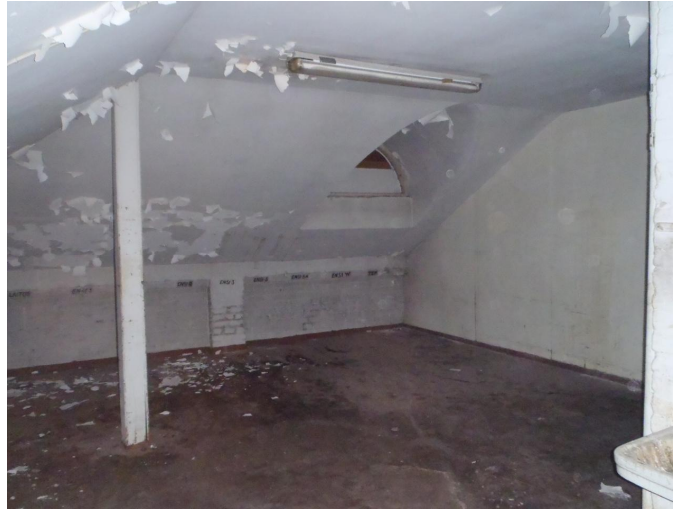
Kuva 5. Valkoinen maali, jolla tehtaan lähes kaikki betoni- ja tiilipinnat on maalattu, sisältää mm. sinkkiä, kobolttia ja lyijyä.
