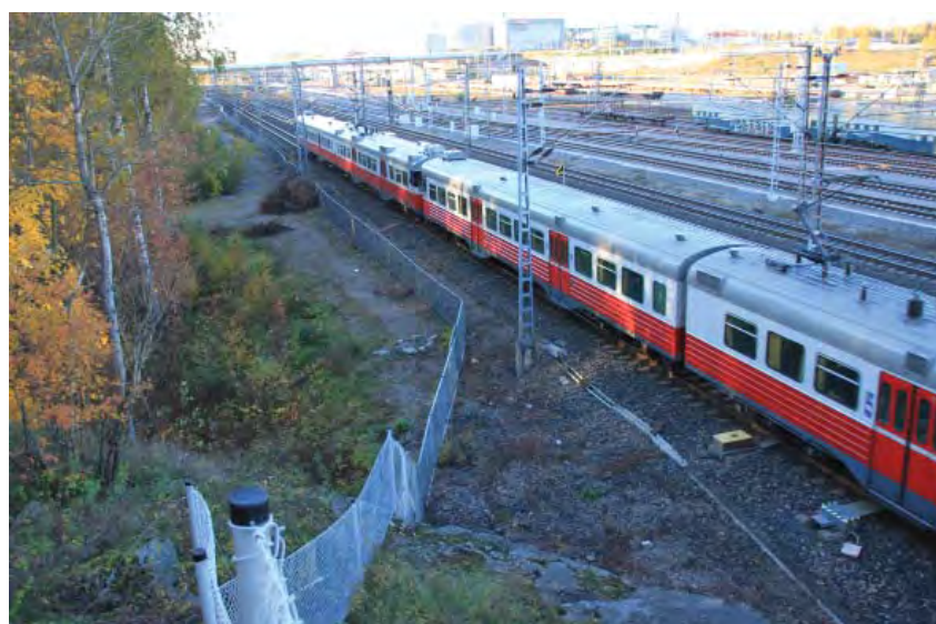
Käpylässä Ratapihantien ja Tuusulantien välisellä noin 1,6 km pituisella jaksolla radan itäreunassa on kaksi isoa kallioleikkausta.
