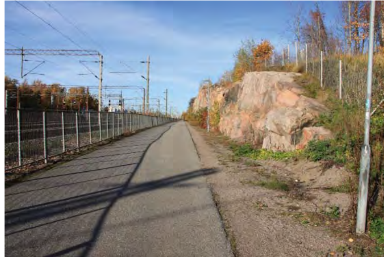
Kallioleikkausta Linnanmäen Alppipuiston eteläpään kohdalla.
