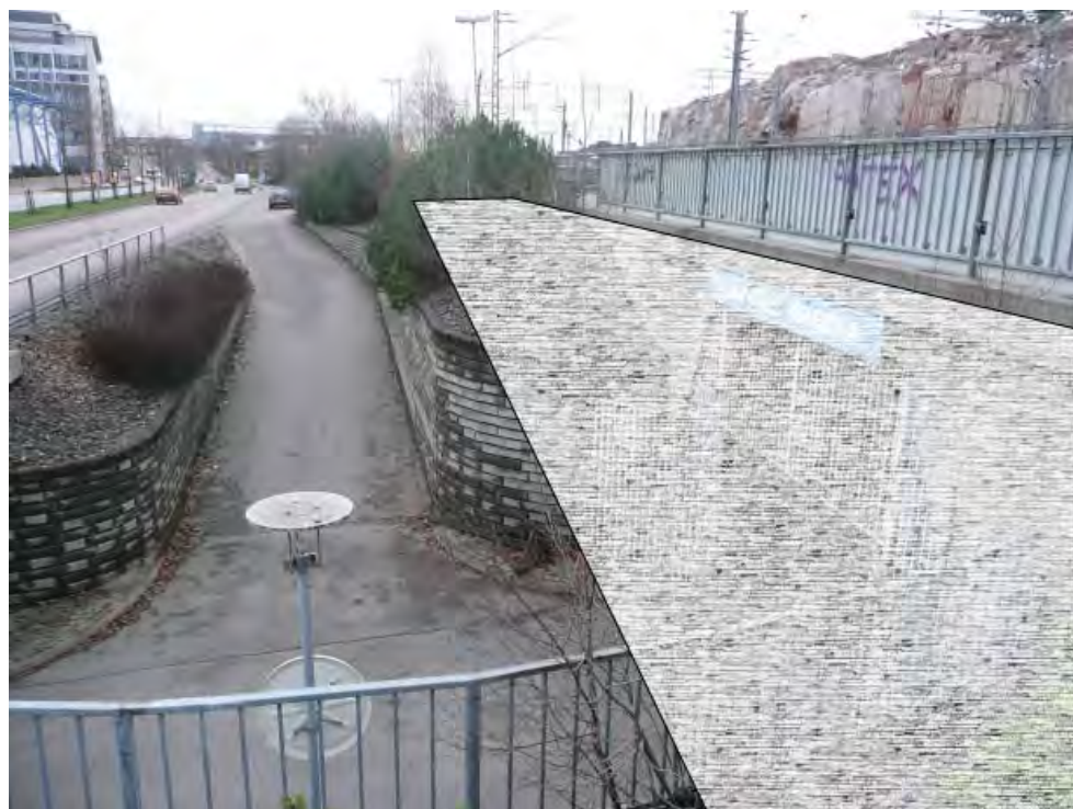
Siltalevitys 3 m Arenan sillan kohdalla.
