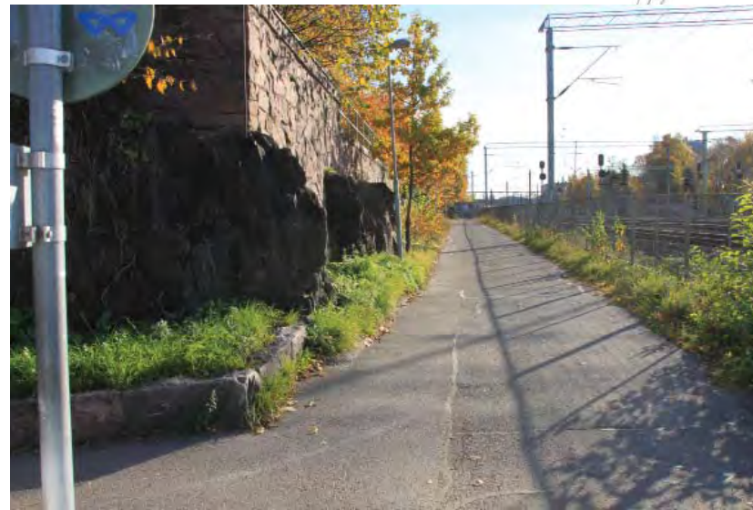
Kallioleikkaus ja tukimuurin Diakonissalaitoksen kohdalla (pl. 770-830), pohjoispää.
