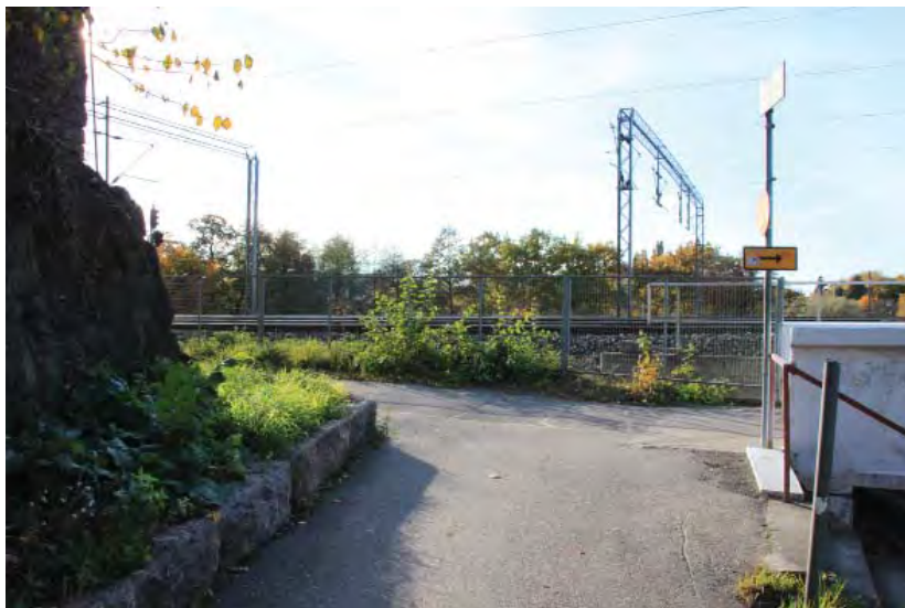
Nykyiset näkemäongelmat sillan eteläpäässä.
