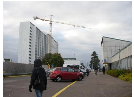
Näkymä vuodetornin ja Syöpäklinikan välistä. Kuva: Sanna Lahti 2013.
