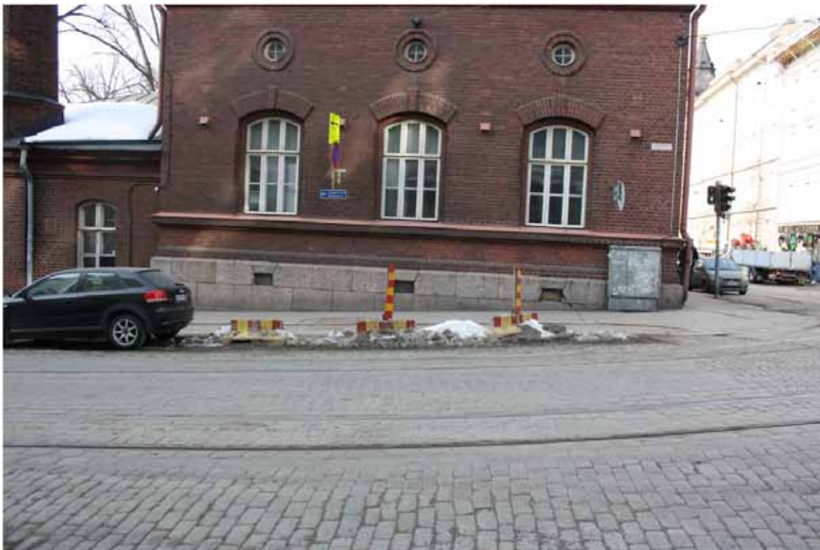
Kuva 15. Betoniset esteet Liisankadun ja Snellmaninkadun kulmassa keväällä 2013. Kuva: Mikko Suhonen
