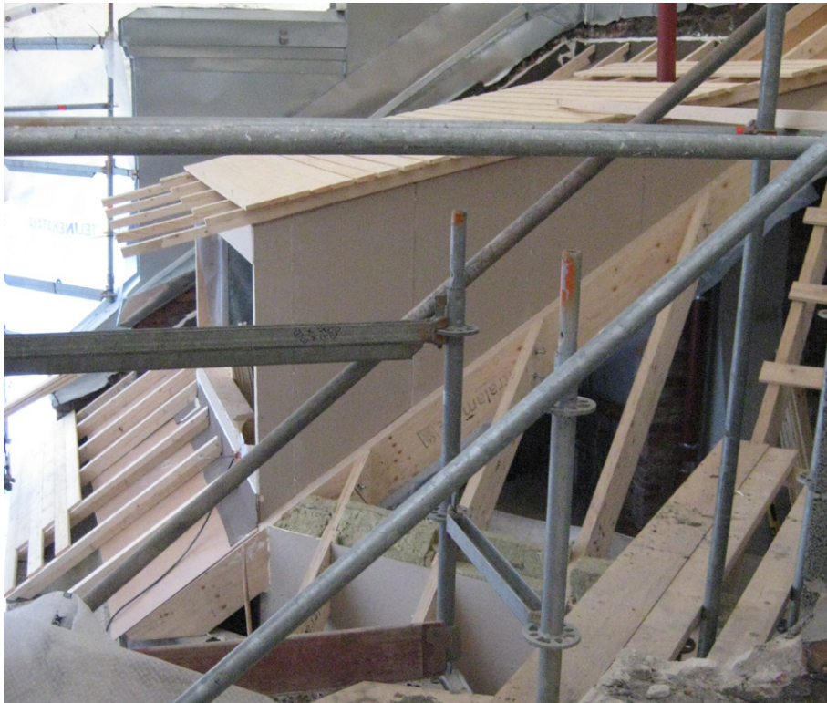
Ullakkoikkunan tekoa Laivastokatu 4:ssä. Suunnittelija Arkkitehtitoimisto Antti Voutilainen Oy. Kuva Heli Virkamäki.
