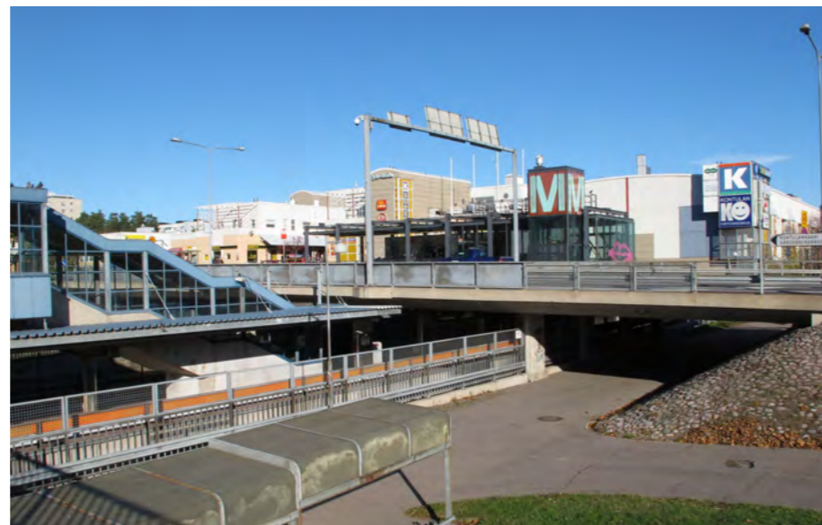
Metroaseman ympäristöä Kontulantien ja Kontulankaaren risteyksessä
