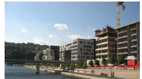
Rantarakentamista Lyonissa. Kuva: Tapani Rauramo
