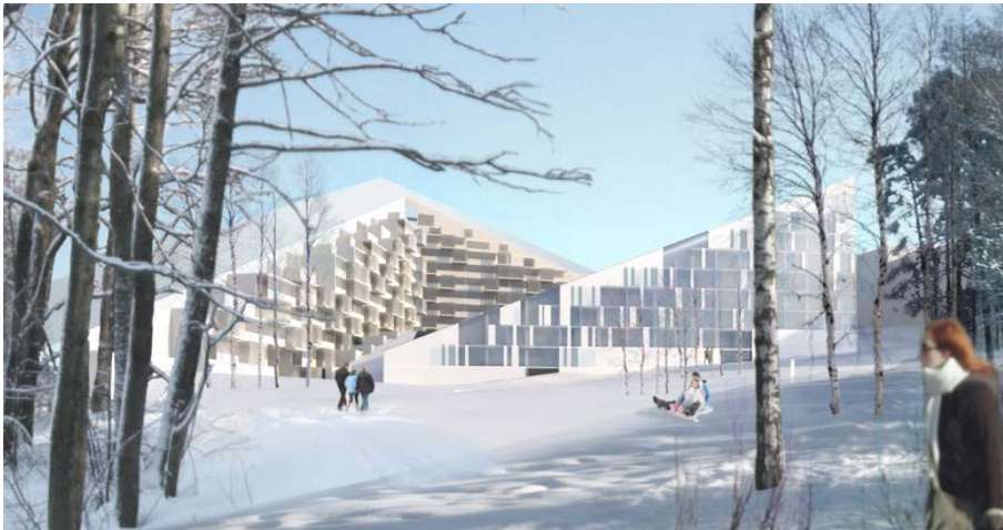
Meri-Rastilan uusi maamerkkirakennus. Kuva: Serum Arkkitechdit Oy
