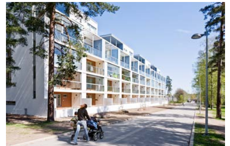
Uutta asuntorakentamista Orpaanportaan varrella Kuva: Simo Karisalo
