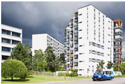
Asuntorakentamista Kontulassa. (Simo Karisalo)
