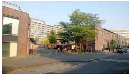
Täydennysrakentamista Bijlmermeerissä, Amsterdam. (Satu Tarula)
