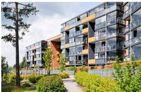
Asuntorakentamista Kannelmäessä. (Simo Karisalo)
