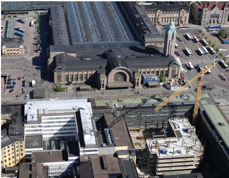
Kuva 3. City-korttelin sisäpihan lisärakennustyömaa vuonna 2010:
