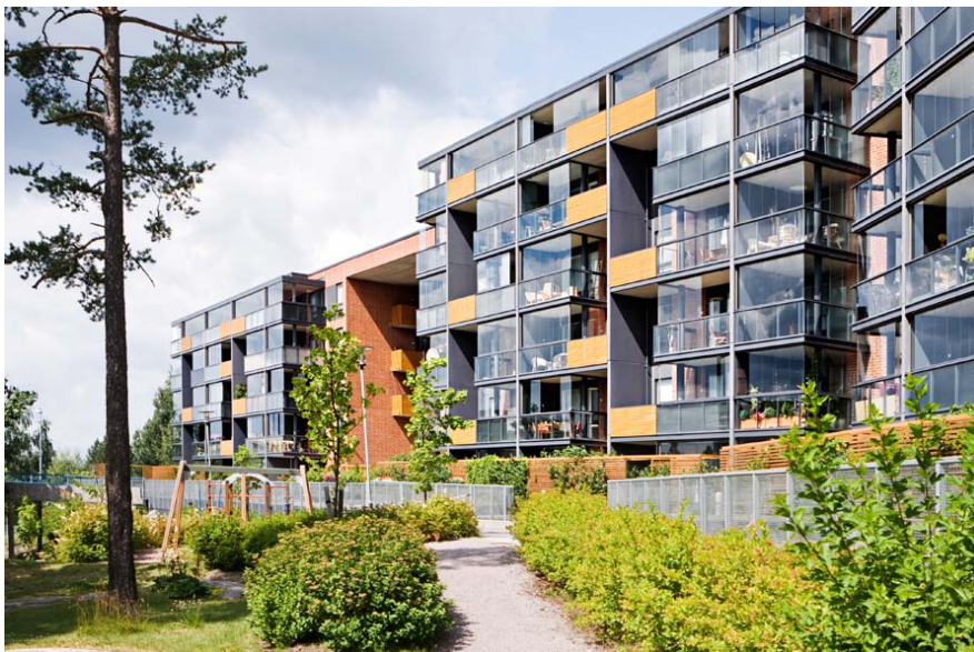
Asuntorakentamista Kannelmäessä. (Simo Karisalo)
