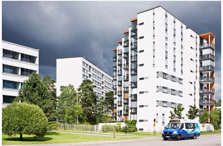
Asuntorakentamista Kontulassa. (Simo Karisalo)
