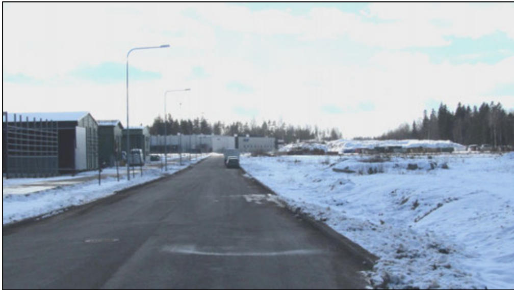
Kuva 4-9. Helikopterikentän ehdotettu sijoittumispaikka Kivikossa kadun oikealla puolella. Taustalla nykyinen välivarastointi- ja esikäsittelyalue sekä vasemmalla puolella pienteollisuusalue.
