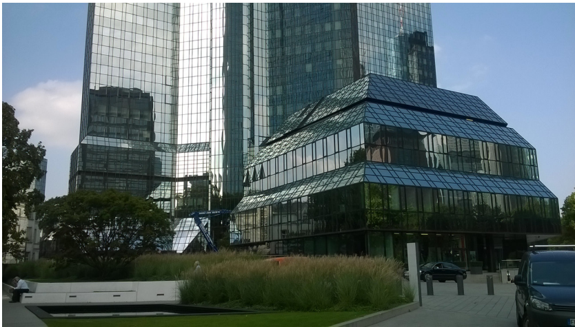
Kuva. Pilvenpiirtäjän yhteyteen liitetty jalustaosa vähentää tuulisuutta ja korkean rakennuksen visuaalista vaikutusta katutasossa, Frankfurt.
