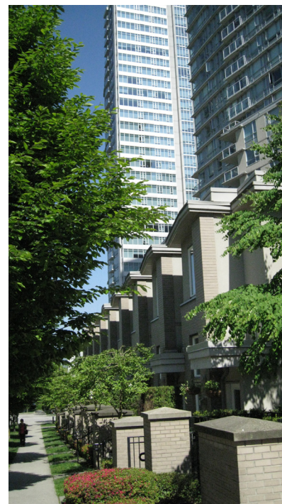
Kuva. Townhouse-asuntoja pilvenpiirtäjän jalustassa, Vancouver.
