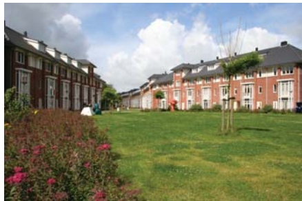
Tiivis townhouse-rakentaminen luo vihrealueelle selkeän reunan. Kuva: Christina Suomi
