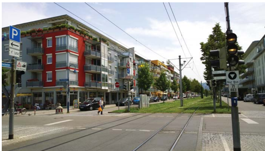
Riesefeld, Freiburg. Palvelut keskittyvät pääkadun varrelle maantasokerrokseen, koska muuta tapaa ei ole sallittu. Kuva: Crista Toivola
