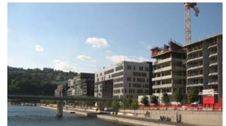
Rantarakentamista Lyonissa. Kuva: Tapani Rauramo
