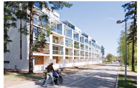
Uutta asuntorakentamista Orpaanportaan varrella Kuva: Simo Karisalo
