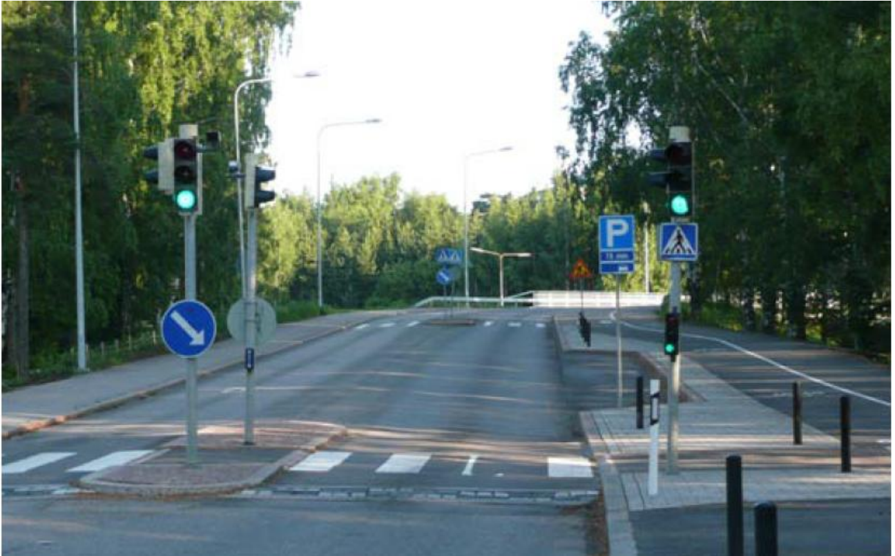
Kuva 13. Koulun saattopysäköintipaikka Professorintiellä. Kohteessa on myös kadunylityksen turvaamista varten tehty korotettu suojatie ja liikennevalot (Kuva: Google-Maps)
