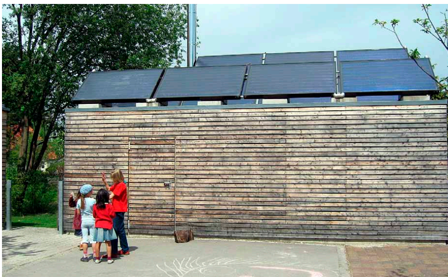
Kuva 6. Asuinalueen lämmön tarve voidaan haluttaessa hoitaa hajautuvaan alueellisella uusiutuvan energiantuotannon järjestelmällä. Korttelikohtainen pelletti- / aurinkolämpökeräinvoimala Münchenissa.
