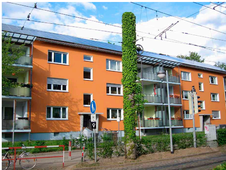
Kuva 9. Energiasaneeraus voidaan yhdistää täydennysrakentamiseen. Kuvan Freiburgissa sijaitsevan kohteen kasvihuonepäästöt on saatu laskettua noin neljännekseen alkuperäisestä eristämällä, lämmitysjärjestelmä uusimalla ja rakentamalla katolle aurinkosähkö- sekä aurinkolämpöpökeräinjärjestelmät. Samalla tonttitehokkuutta kasvatettiin noin 50 % uudella rakentamisella ja tiivistettiin kaupunkirakennetta raitiovaunuverkoston varrella.
