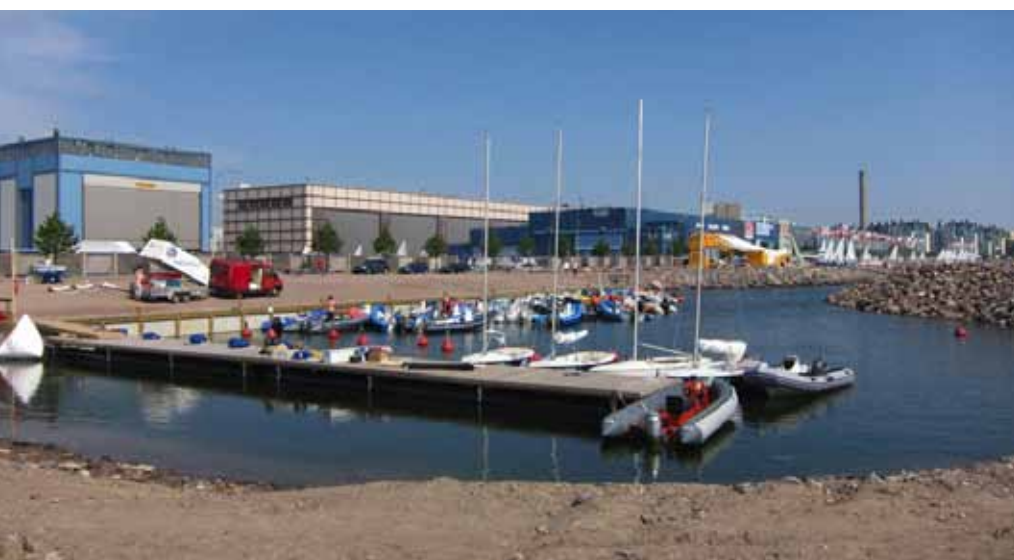
Hernesaaren väliaikainen vesibussilaituri 2011
