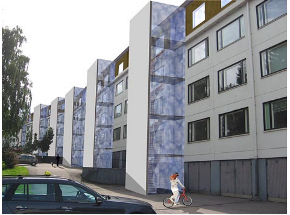
Isonvillasaarentie 2:n kadun puoleinen julkisivu korotuksen ja hissitornien lisäyksen jälkeen.
