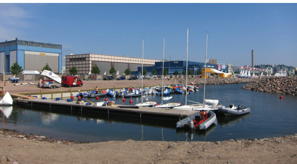
Hernesaaren väliaikainen vesibussilaituri 2011
