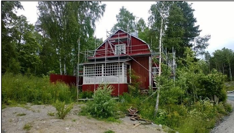
Kuva 20. Kaivoshuvilan maalaustyö on melkein valmis.
