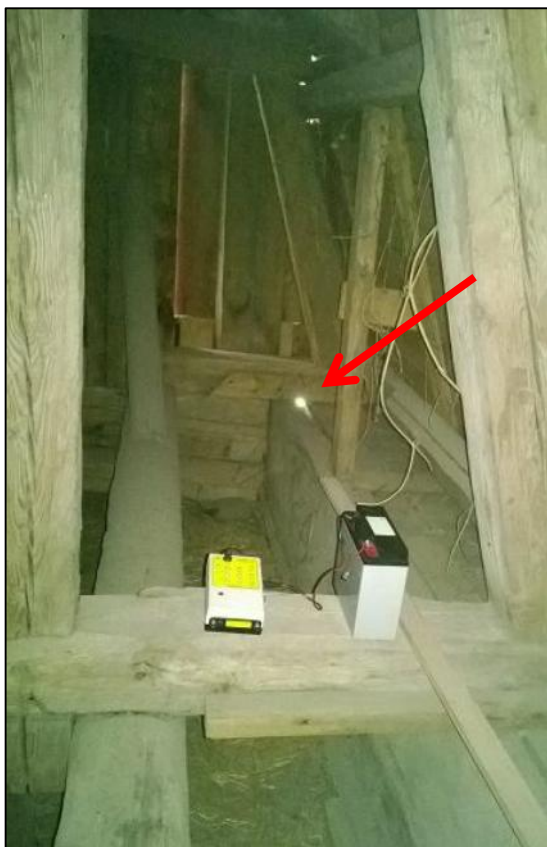
Kuva 5. Kaivoshuvilan ullakolla ollut passiiviseurantadetektori ja siihen kytketty akku. Punainen nuoli osoittaa koloa, josta lepakot pääsevät rakennukseen.
