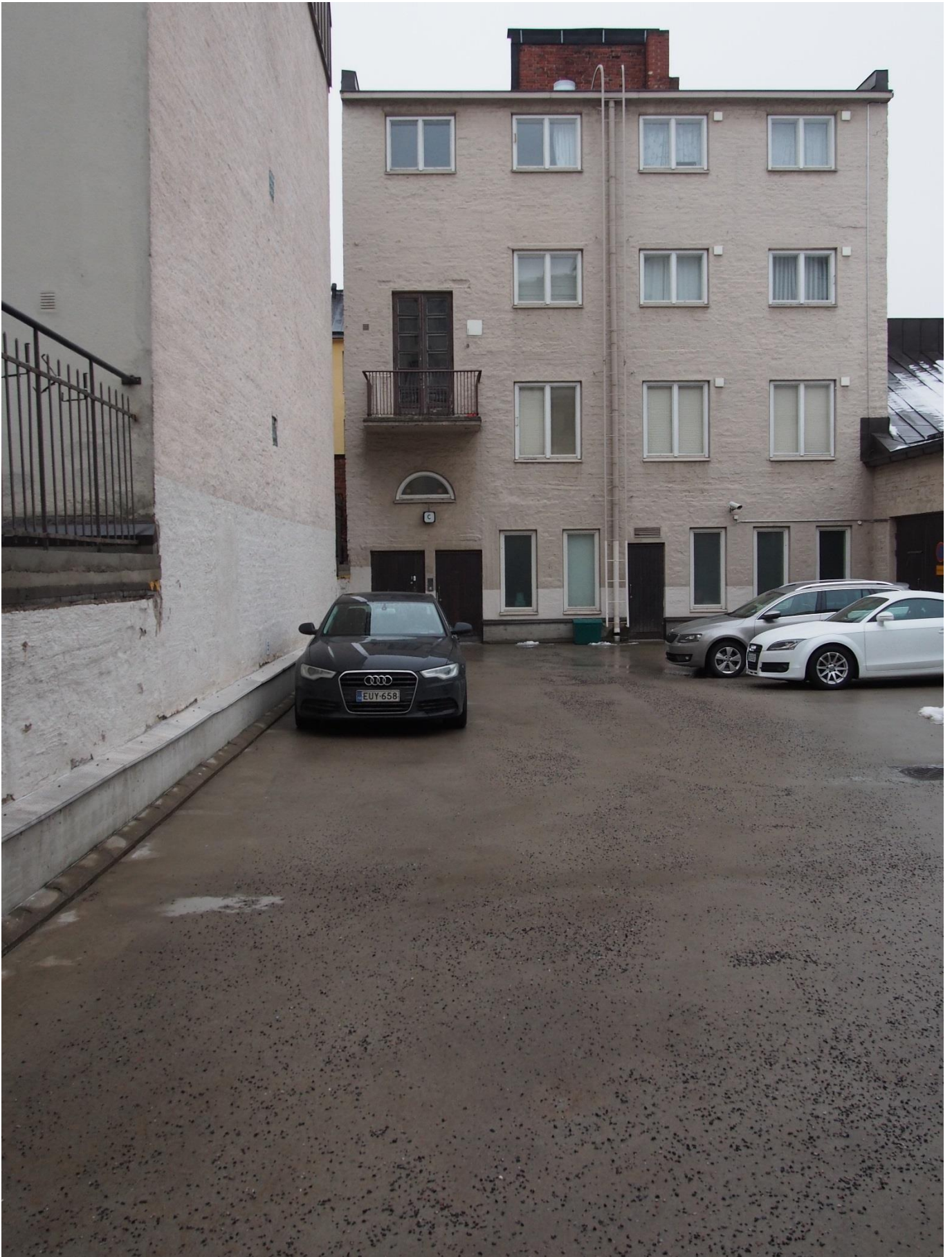
Liisankatu 14, tontin kaakkoiskulmassa sijaitseva nelikerroksinen asuinrakennus. Kuva: Sakari Mentu
