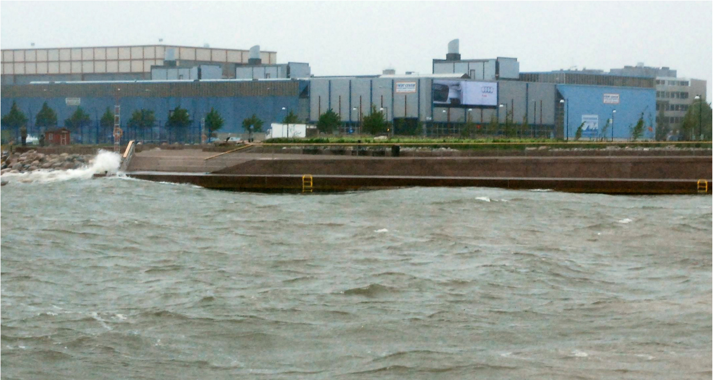
Kuva 4. Aallokkoa 23.6.2011 Hernesaaren rannassa (K. Tikka). Aallonkorkeus kuvassa noin 1 m. Kuva edustaa keskimäärästä roiskeiden nousukorkeutta 3,2 m pystysuorasta muurista tällä aallonkorkeudella.
