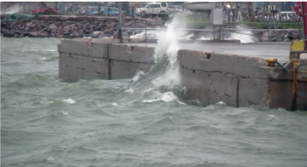
Kuva 7. Heijastunut aalto ja siitä syntyneet roiskeet Hernesaaren kärjessä 23.6.2011 Vihreä vesi nousee juuri ja juuri laiturin tasalle. Kuvassa on syytä kiinnittää huomiota siihen, miten korkealle aalto nousee verrattuna kaikkiin muihin kuvassa samanaikaisesti näkyviin aaltoihin verrattuna. Kuvan perusteella voidaan todeta, että aaltoiluvara on Hernesaaren eteläkärjessä vähintään 1,7 m Roiskeet nousevat kuvassa vajaan 2 metriä sen yläpuolelle eli 3,5 m keskiveden yläpuolelle. (Kuva K. Tikka).
