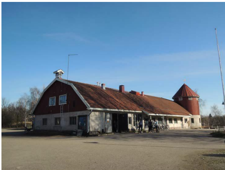
Karjasuoja, kotieläinpihan päärakennus
