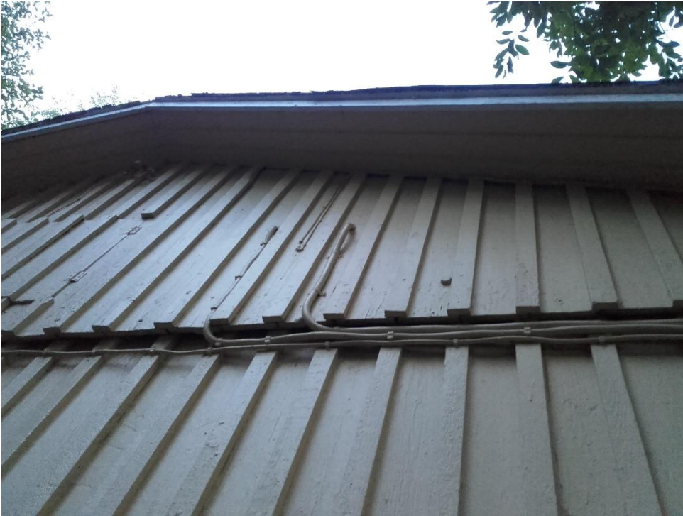
Rakennus 17 terminaali-alueella. Päätylaudoituksen alla on lepakonmentäviä rakoja. Ne tarkastettiin taskulampulla, mutta lepakoita ei havaittu.
