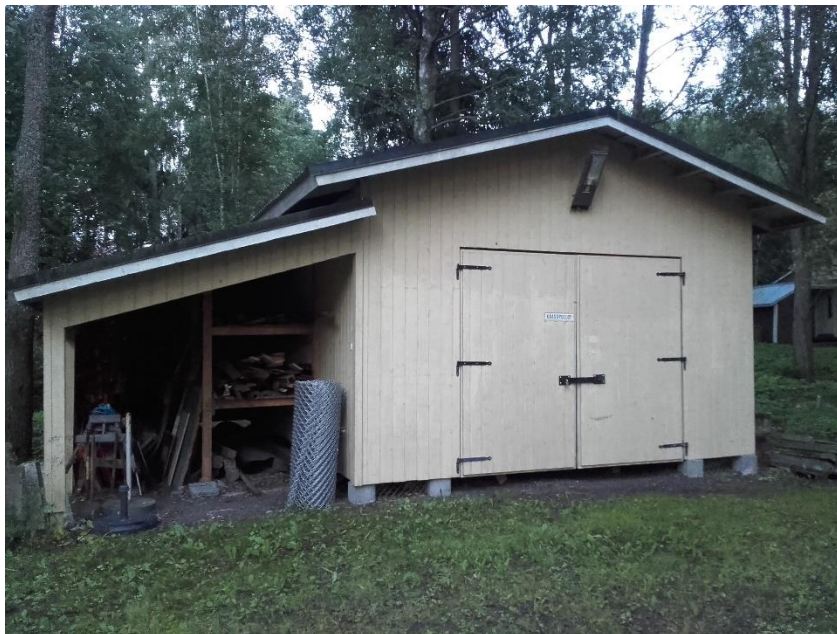
Kuva 3. Varastokentän vaja 17b, jossa sijaitsi päiväpiilo. Piilo oli rakennuksen oikeanpuoleisen nurkan kohdalla ilmeisesti seinän sisässä.
