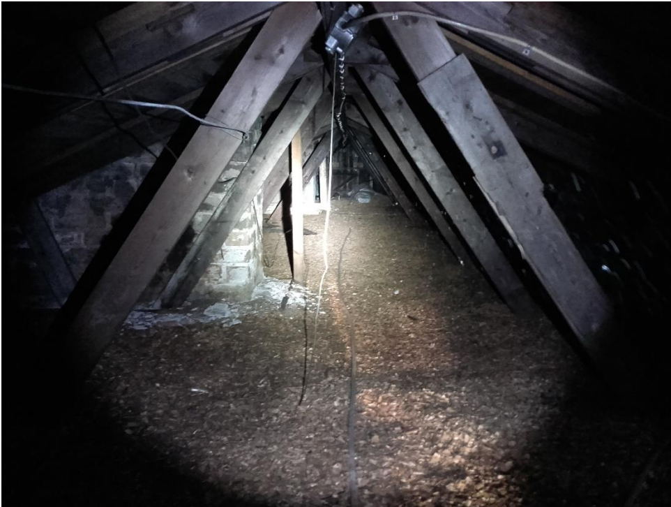
Rakennuksen 17 vintti. Merkkejä lepakoista ei havaittu.
