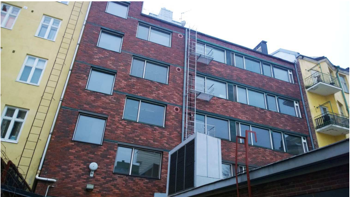
Pihajulkisivu, osa ikkunoista uusittu 1997
