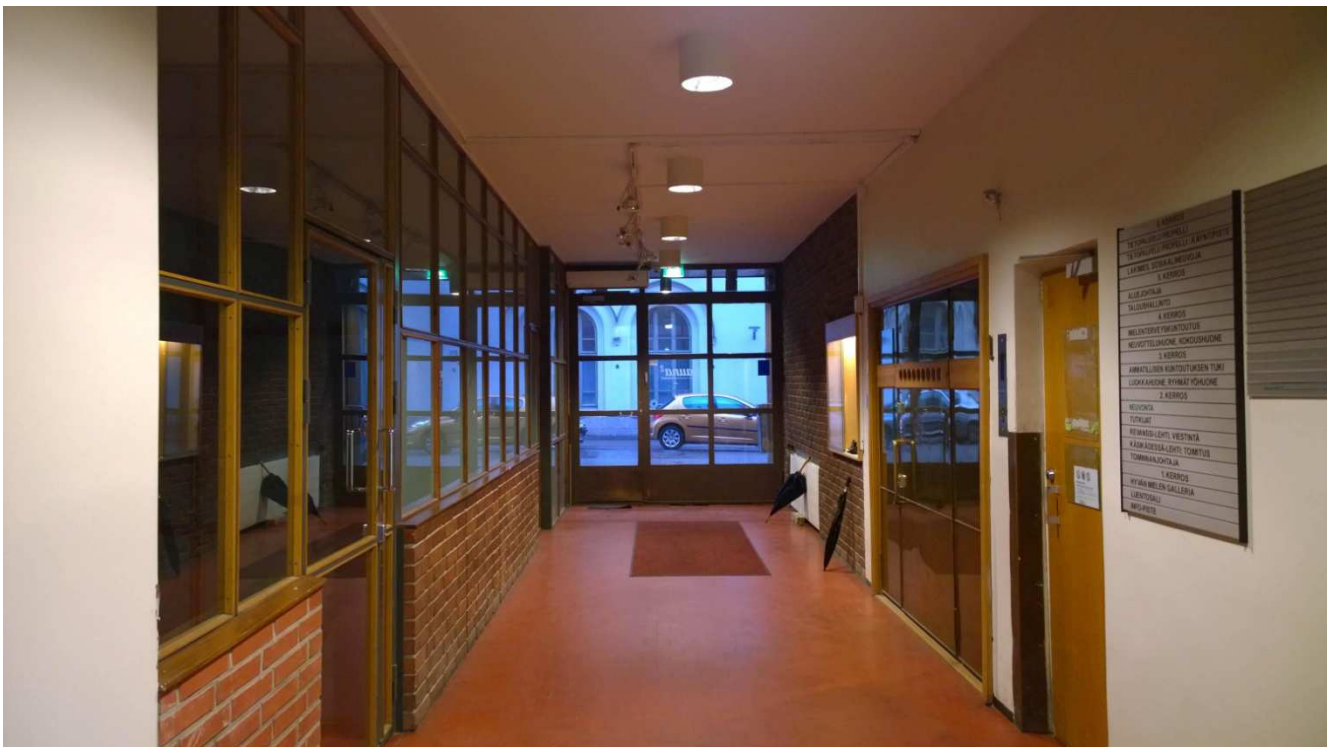
Sisäänkäyntiaula säästy palolta. Aluperin avoimet porrastilat vasemmalla seinällä on suljettu
