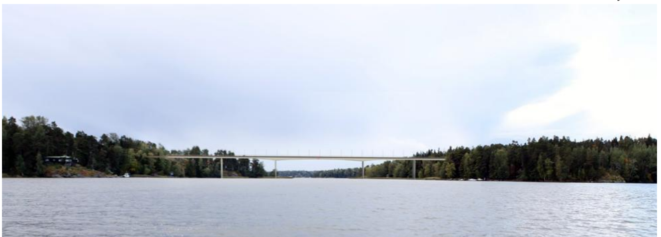
Ramsinsalmensilta, 2012, Fundatec Oy, Ksv.
