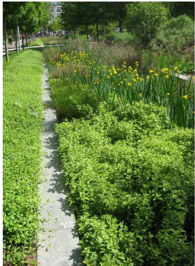
Hulevesipainanne kasveineen, N Strengell, Ksv.
