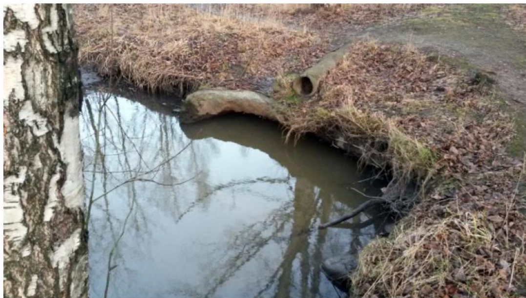
Kuva 6 Haaganpuron siltarummun purkukohta.
