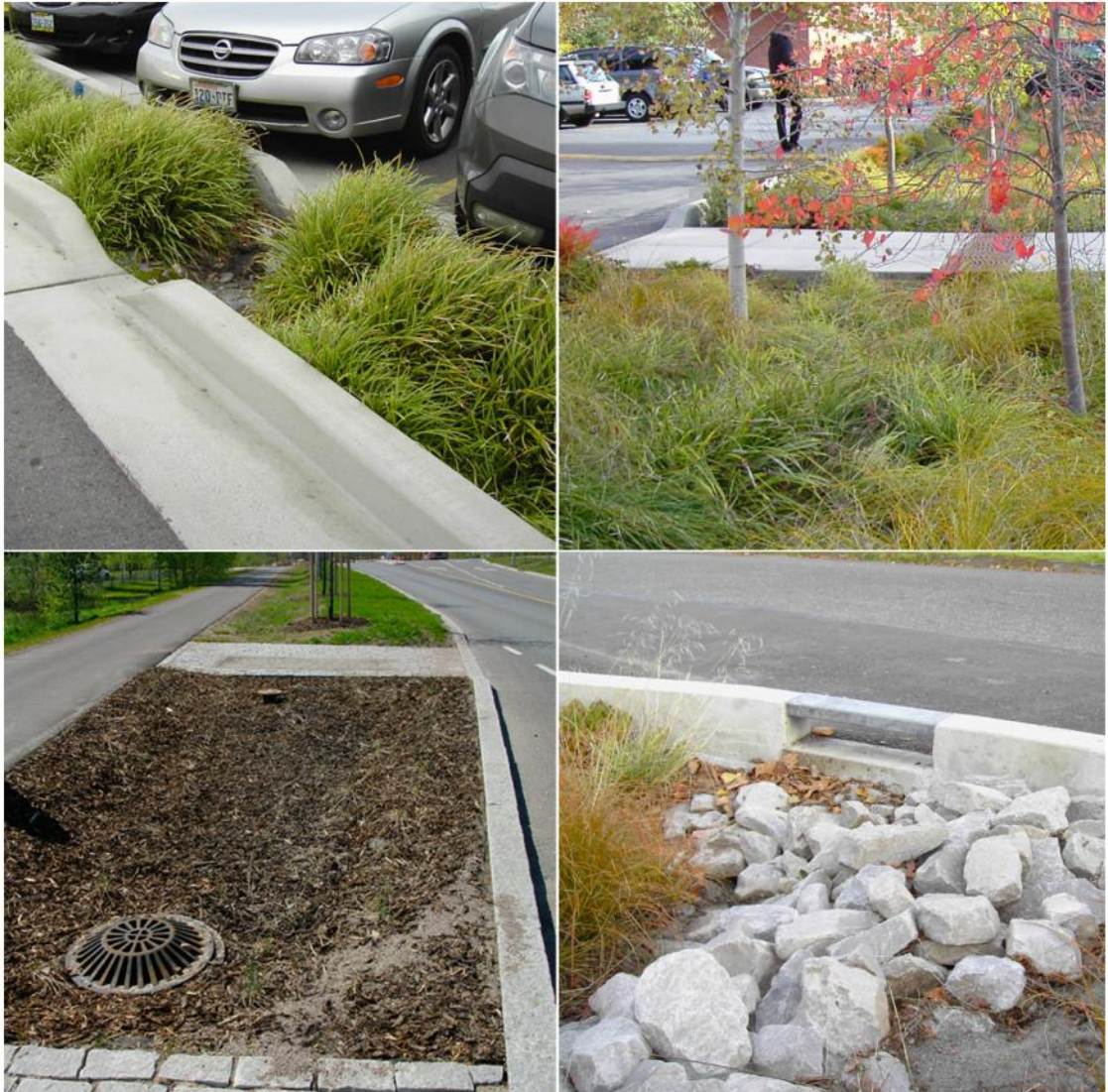
Kuva 10. Esimerkkejä biosuodatusrakenteista.
