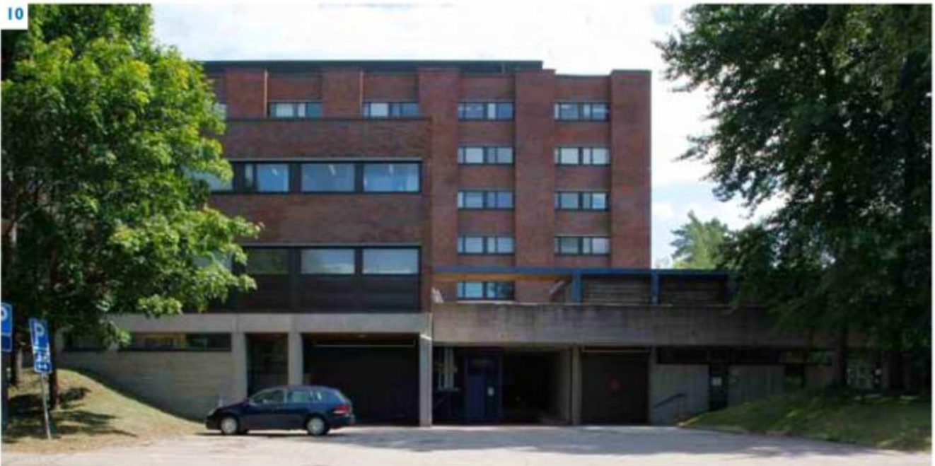
Näkymä paikoitusalueelta kohti hammasklinikan C- ja B-osan länsijulkisivuja.
