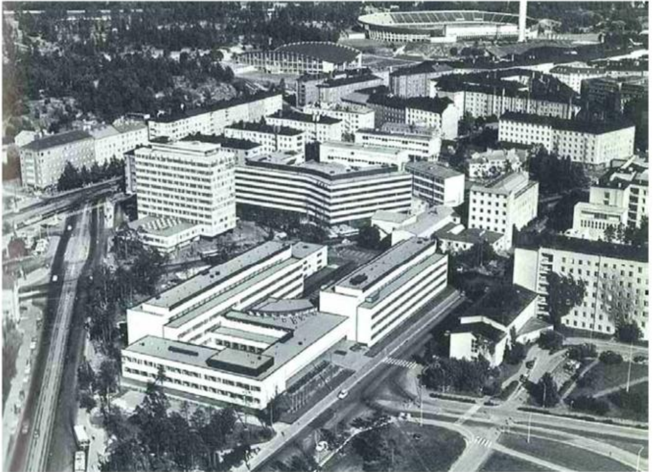
Arkkitehti Einari Teräsvirta suunnitteli 1966 valmistuneet lääketieteen teoreettiset laitokset Haartmaninkadulle (alhaalla keskellä). Rakennukset ovat 1960-luvun tasakattoisuuden ja vaalean elementtirakentamisen tyyppillinen esimerkki. Kuva Klingenin kirjasta Helsingin yliopisto 1917-1990, osa III, 623.
