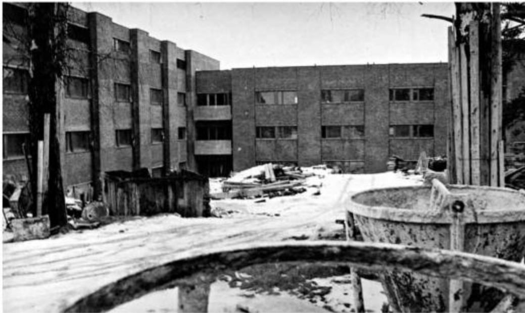
Oikeuslääketieteen laitos rakentella. Kuva on otettu viimeistään vuonna 1974. Kuvassa näkyy, että rakennusalueella olevat säilytettävät puut suojattiin laudoituksella. HYM.
