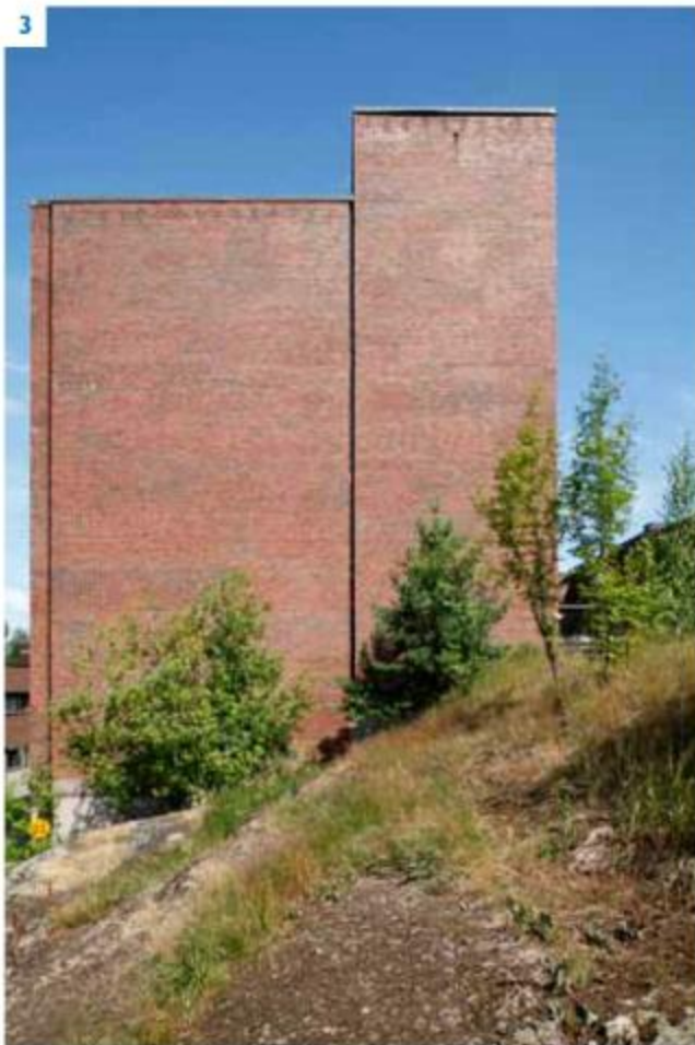
Ikkinaton, muurimainen julkisivu B-osan eteläpäädyssä rinnastuu koskemattomaan peruskallioon.
