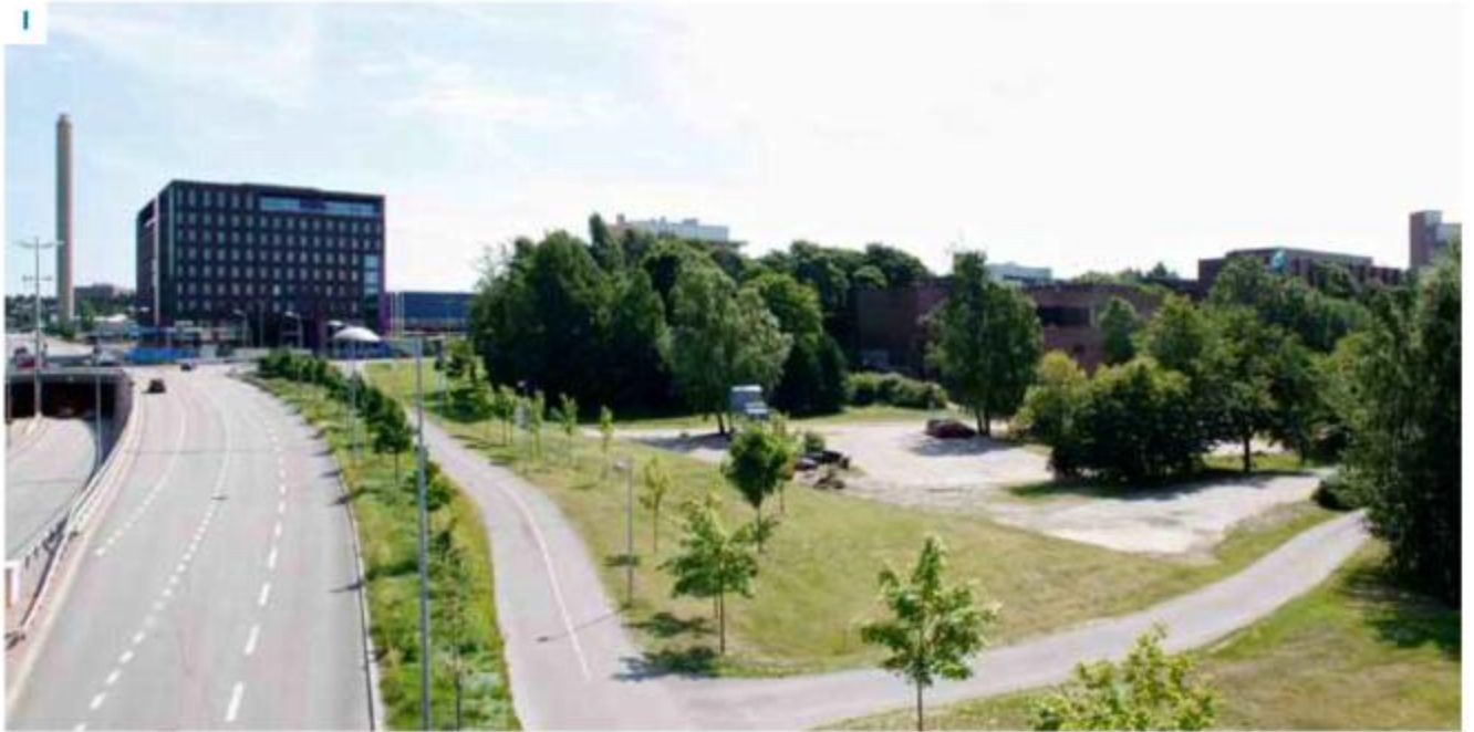
1 Näkymä Vihdintien ylittävältä kävelysillalta kohti itää. Etualalla näkyy oikeustieteen laitoksen parkkipaikka. Itse laitosrakennukset jäävät lehtipuiden taakse piiloon.
