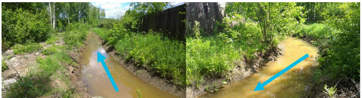
Kuva 11. Autotallintienoja kiertää Tattarisuon autovarikon. Uomaa on hiljattain perattu ilmeisesti heikon vedenjohtavuuden parantamiseksi. Pienen vieton johdosta vesi seisoo uomassa. Autotallintienoja yhtyy Longinojan alkupäähän noin 100 metriä alavirtaan kuvauskohdasta.
