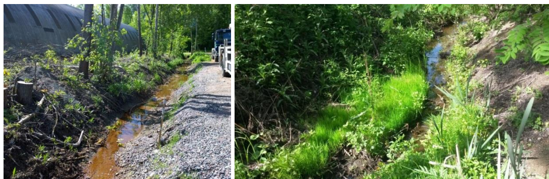
Kuva 13. Tattarisuolla ei ole hv-viemäröintiä. Vasemmalla purkureitti Jäähdytintien eteläpäästä etelään metsän läpi kohti Jarrutienojaa. Jarrutienojan vietto on pieni ja vesi seisoo uomassa monin paikoin (oik.)
