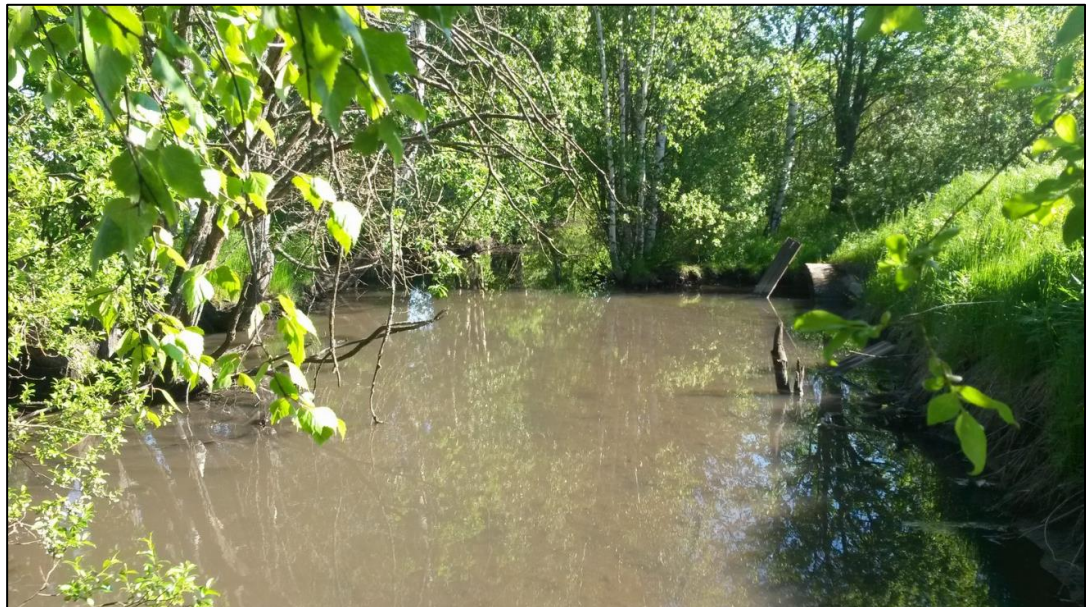
Kuva 15. Pumppaamonpuron putkituksen purkukohta Longinojassa. Kuvaushetkellä (9.6.2015) virtaama putkesta Longinojaan oli noin 5 l/s. Purkautuva vesi oli kirkasta ja erottui selvästi Longinojan savisameasta vedestä.
