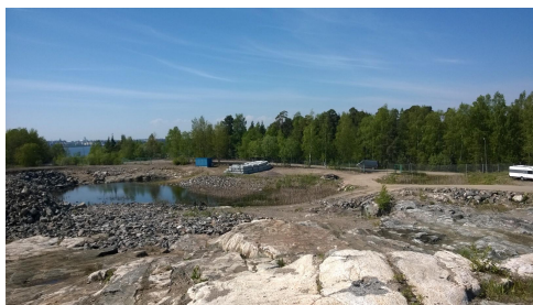
Öljysataman toimintaan liittyvät rakenteet on purettu
