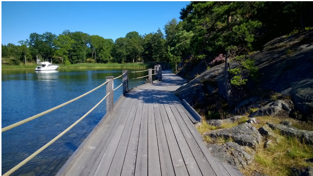
Kalliojyrkänteiden kohdalla rantareitti voi kulkea puisia rakenteita pitkin. Kuva: Ritva Luoto.
