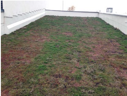
Kuva 35: Viherkatto Herttoniemen uudisrakennuskohteella.
