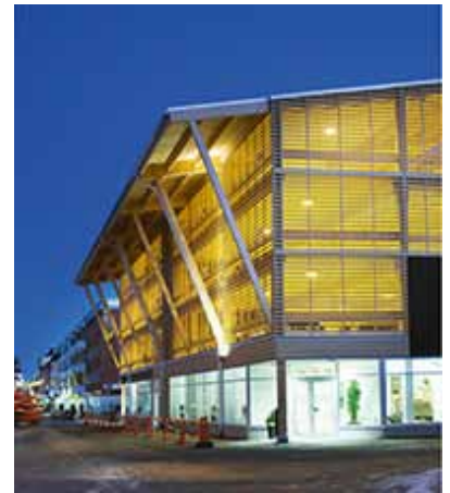
Puurakenteinen pysäköintitalo, jossa maantasokerros liiketiloja, Ekorren, Skellefteå. Kuvälähde: www.svensktra.se
