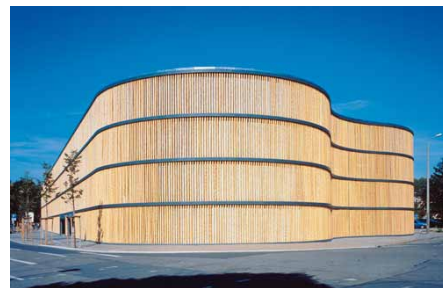
Pysäköintitalo, julkisivu bambua, Leipzig. HPP Architekten. Kuvalähde: www.hpp.com
