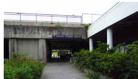
Pukinmäen aseman sisäänkäynti pyöräpysäköinteen
