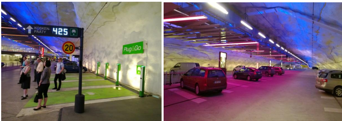
Maanalainen älykäs ja Hämpä-parkki sähköautojen latauspisteineen Tampereelta. Liityntäpysäköinti palvelee niin ydinskekkustan liiketiloja kuin junalla matkustavia ja on käytettävyydeltään ja käyttökokemukseltaan huippuluokkaa. Kuvat Christina Suomi
