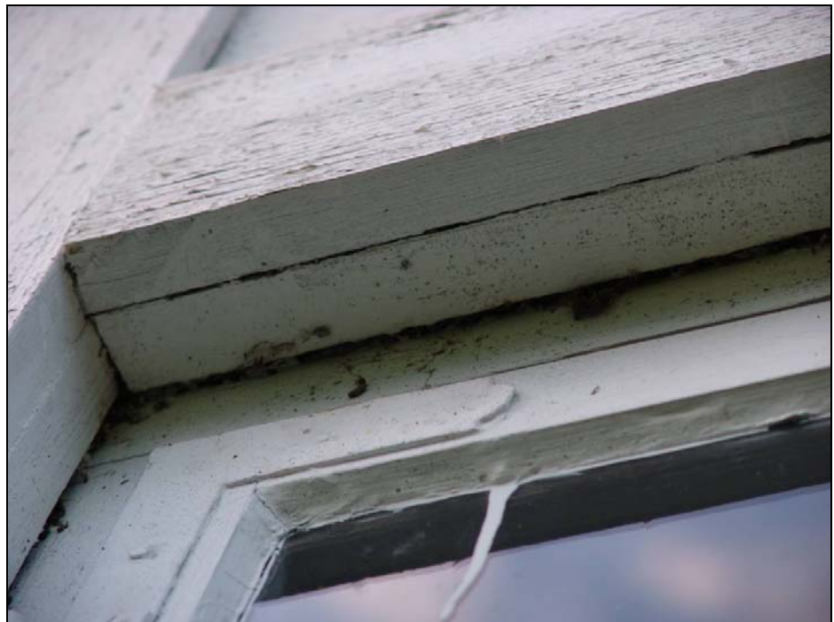
Kuva 15. Lepakoiden päiväpiilo voi olla esimerkiksi ikkunan yläpuolella olevassa kapeassa raossa (kuva: Terhi Wermundsen).
