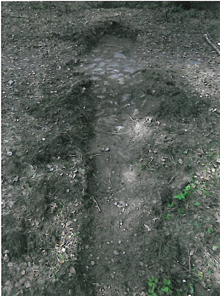
Tykkitien poikittainen koeaja kiveyksen leveyden toteamiseksi. Kiveystä oli tien keskiosassa. Reunoissa oli hiekan ja kivien muodostamat vyöhykkeet. Kuvaussuunta SE. 5.5.2011.
