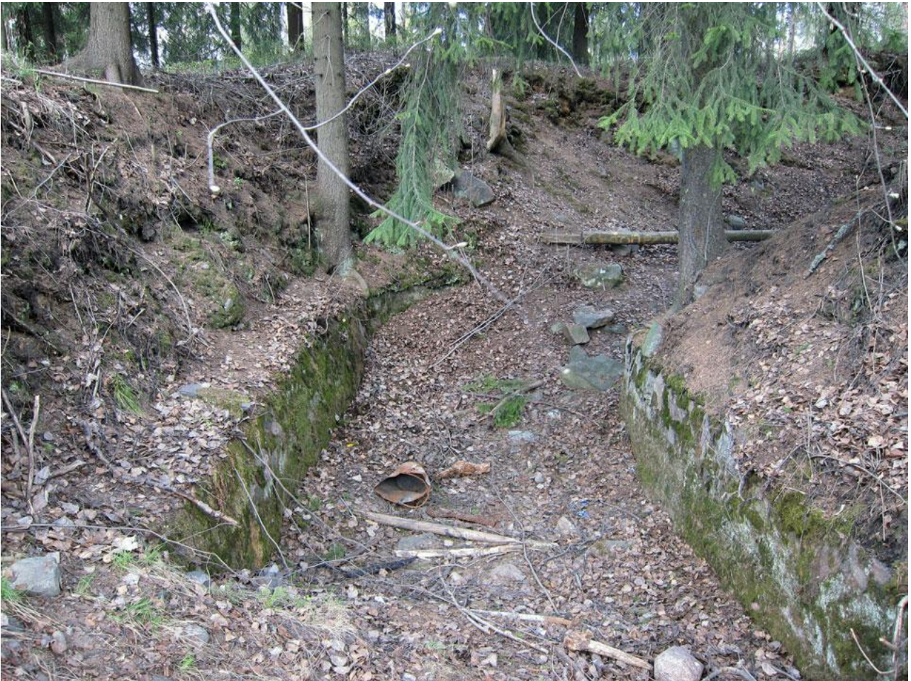
Asema 1:n yhdyshaudan keskiosan alaosa harkkomuureineen. Kuvaussuunta N. 5.5.2011.
