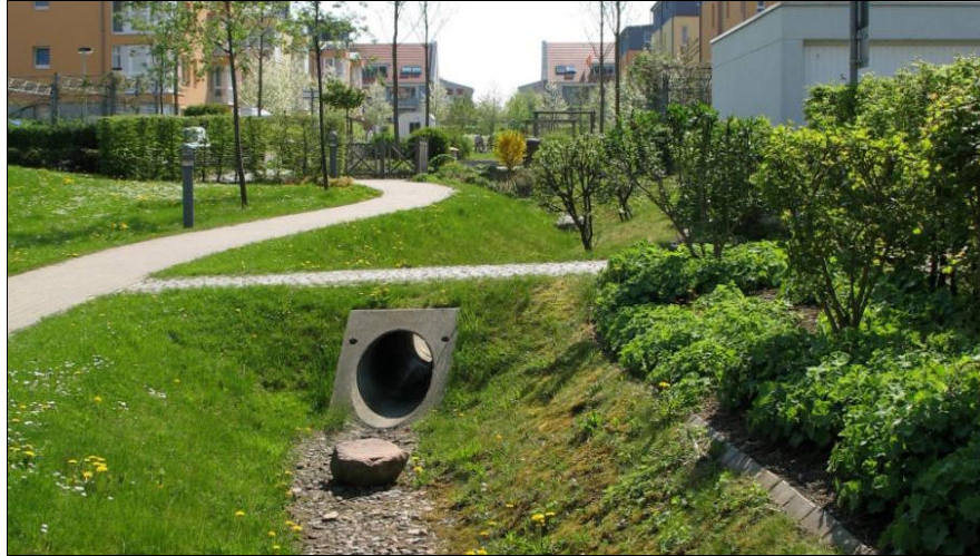
Kuva 36. Avo-oja yleisellä puistoalueella johtaa asuinalueen hulevedet. 7
