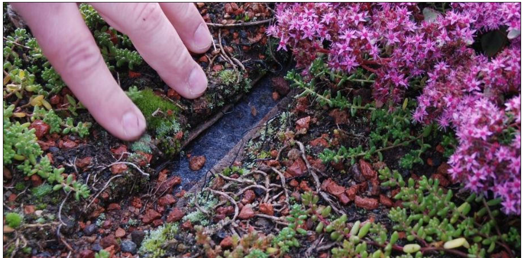
Kuva 22. Esimerkki ohuen sammalmaksaruohokaton rakenteesta Suomen olosuhteissa. Kohde on Espoon Solvallon urheiluopisto. Vesieristeen päällä juurenestomatto, salaojamatto, geoverkko sekä kasvu- ja kasvillisuuskerros. 7
