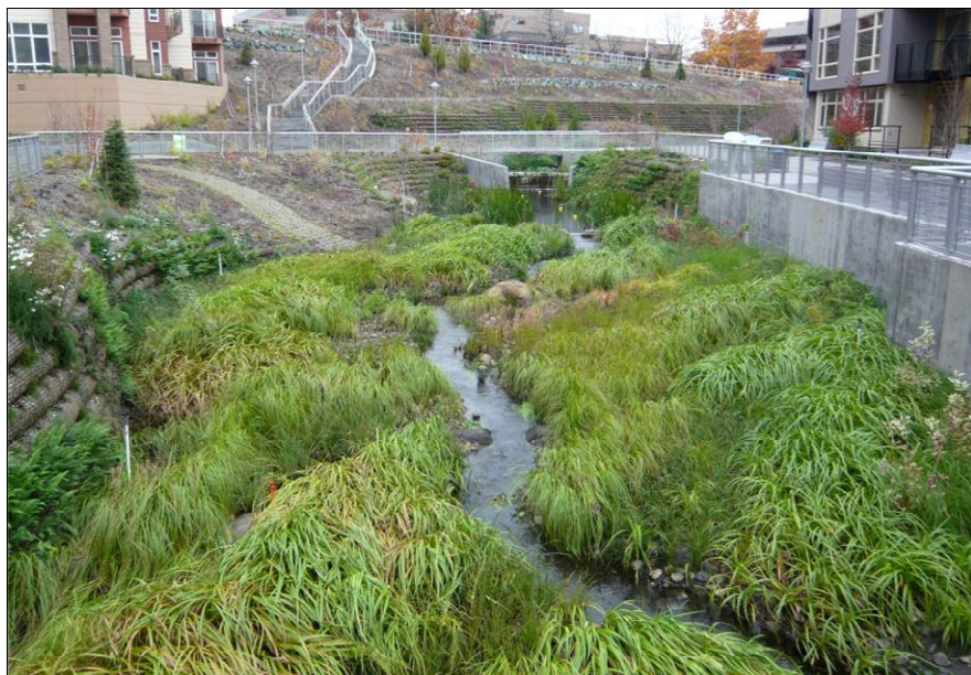
Kuva 38. Esimerkki puron johtamisesta tiiviin rakennetun alueen sisällä. Thornton Creek, Yhdysvallat. 7
