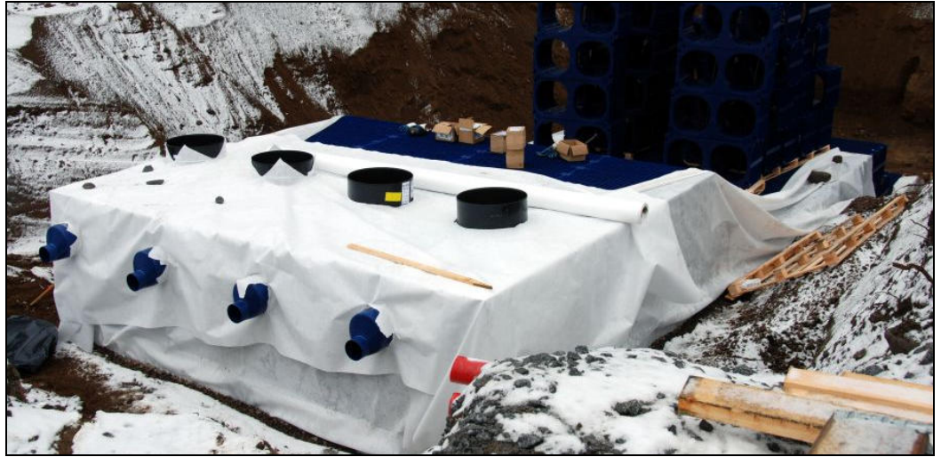
Kuva 32. Maanalaisen 300 m 3 kennoston rakentamista Tampereella 7
