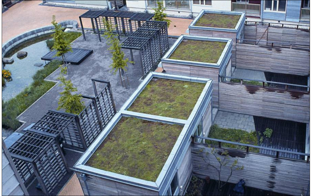
Kuva 29. Esimerkki korkeatasoisesta tontti- ja korttelikohtaisesta hulevesien hallinnasta. Malmö, Västra Hamnen, Ruotsi. 18
