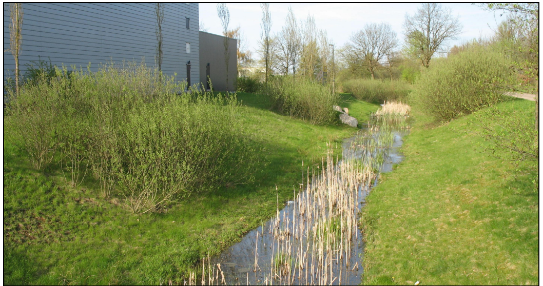
Kuva 39. Hulevesien viivytyispainanne on sijoitettu tonttien reunaan. 7
