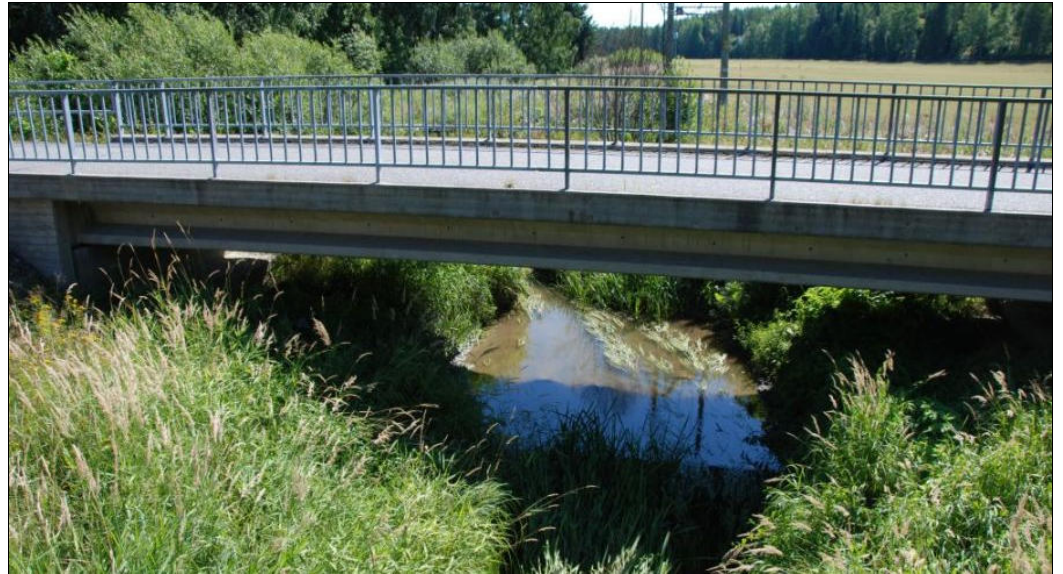
Kuva 9. Krapuojan alittaa Uuden Porvoontien ja sen kevyenliikenteenväylän. 7
