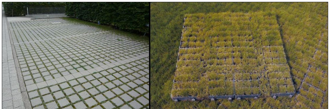
Kuva 28. Esimerkkejä läpäisevistä päällysteistä. Vasemmalla väljästi saumattu kiveys 7 ja oikealla vahvistettu nurmirakenne. 18
