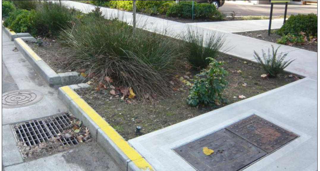
Kuva 35. Katualueen hulevesien hallintaa vihertaskuilla.
