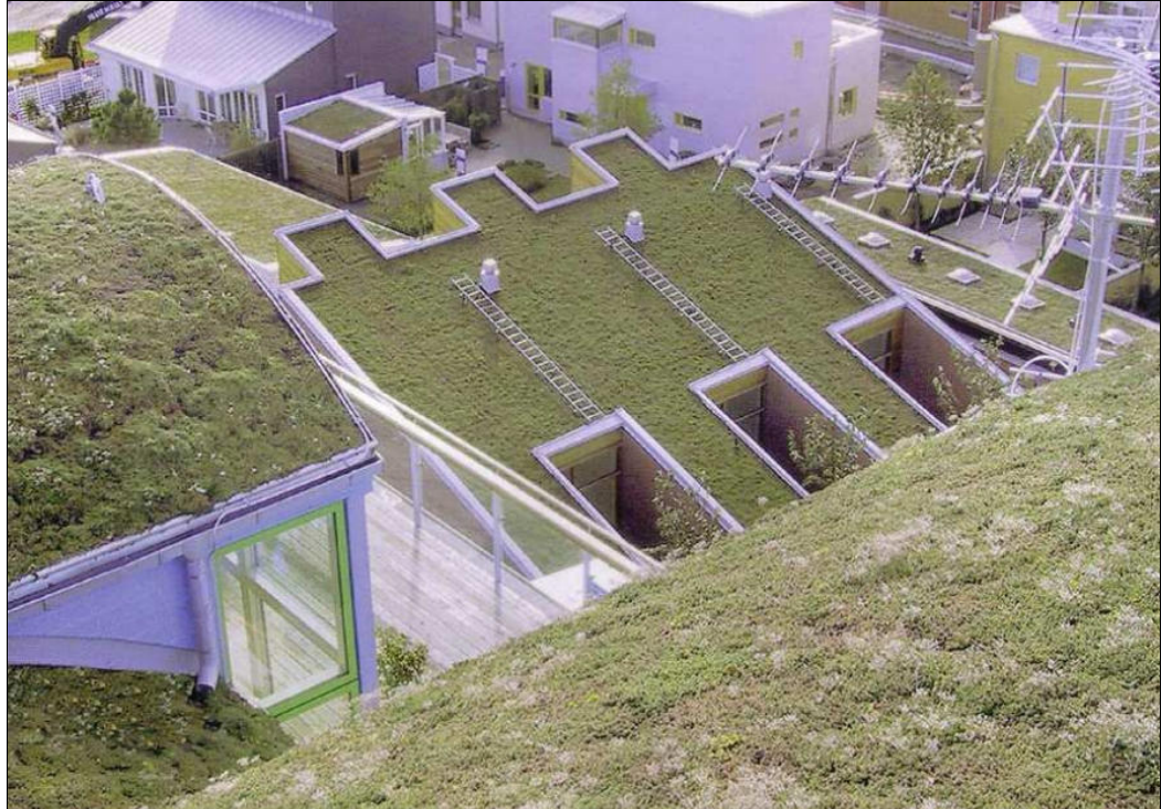
Kuva 23. Sammal-maksaruohokerroksella toteutettuja viherkattoja. Malmö, Västra Hamnen, Ruotsi 18
