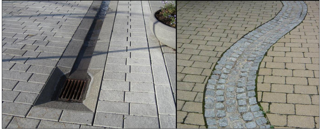
Kuva 30. Esimerkkejä korkeatasoiseen hulevesien pintajohtamiseen. 7
