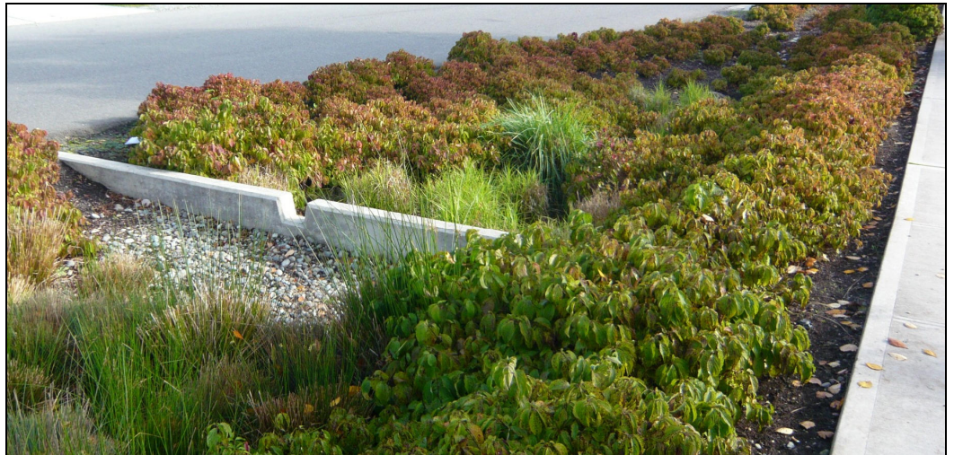
Kuva 34. Katualueen viherpainanne, johon on istutettu kasvillisuutta ja rakennettu virtausta hidastavia pohjapatoja. 7
