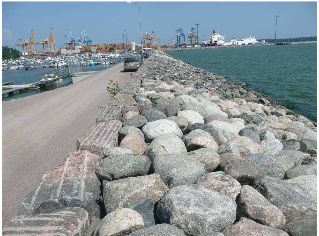
Kuva 11. Luiskan louheverhous. Etualalla maakiviverhous ja taustalla louheverhous. Tien reunassa on raakakivistä tehty muuri. (Vuosaaren satama)
