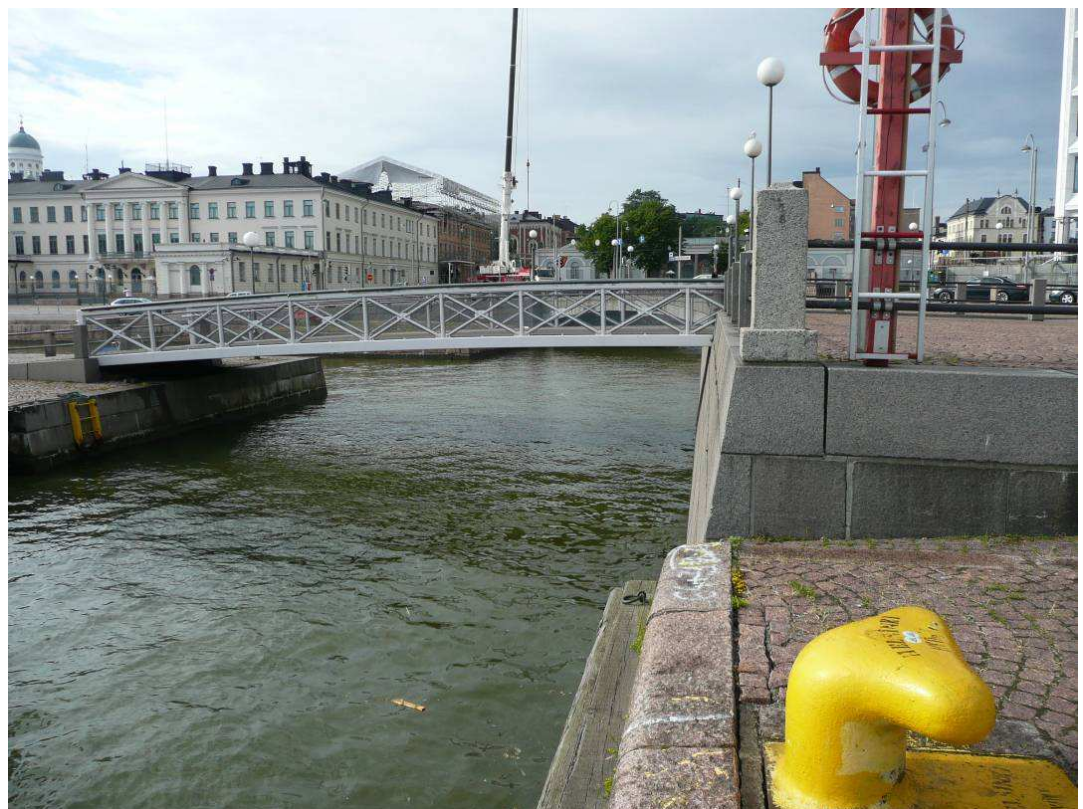
Kuva 9. Esimerkki kanavan ylittävästä kevyen liikenteen sillasta. (Kauppatori)
