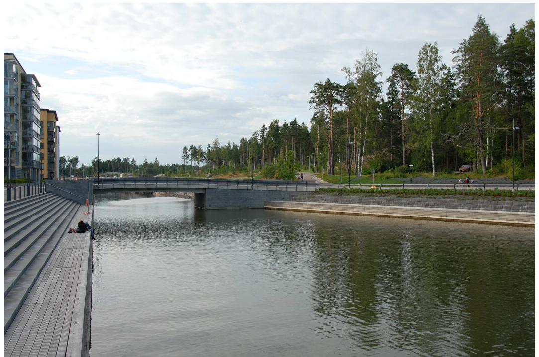
Kuva 8. Esimerkki kanavan ylittävästä ajoneuvoliikenteelle suunnitellusta sillasta (Uutelan kanava)
