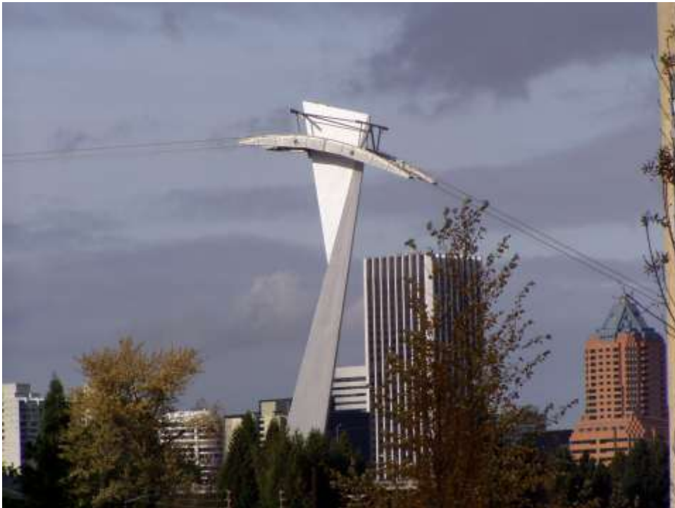
Kuva 19. Portlandin köysiradan tyylitelty tukipylväs kaupunkirakenteessa (Doppelmayr).
