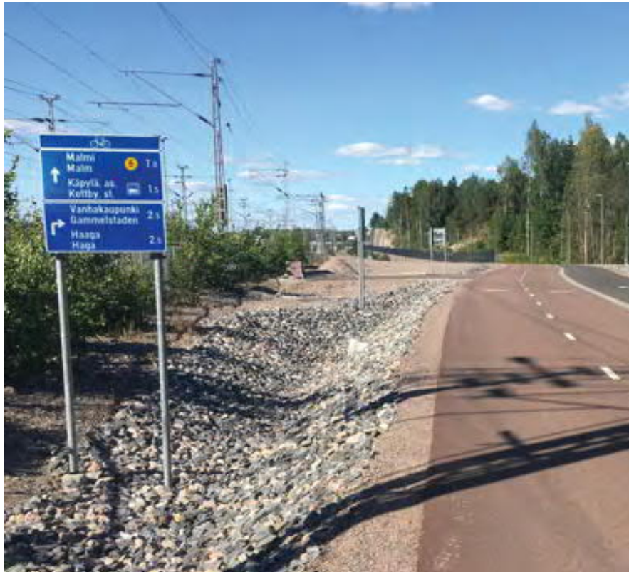
Kuva 22. Pyöräliikenteen opaste rakennetulla Pohjoisbaanan osuudella. (HSL 2020)
