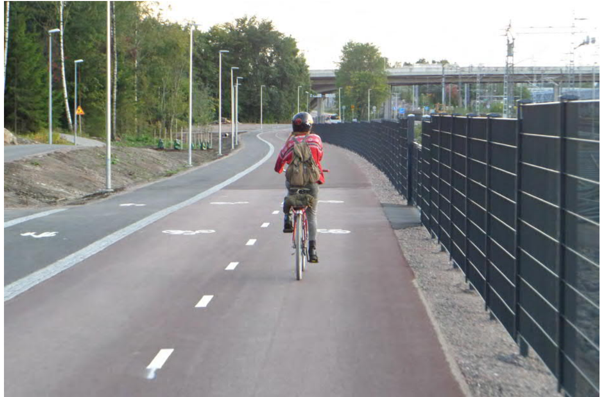
Kuva 9. Baana tukee pyöräilijöiden ja jalankulkijoiden turvallista ja sujuvaa liikkumista, sillä kulkumuodot erotellaan toisistaan välikiveyksellä.
