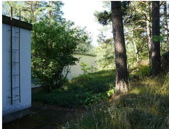
Kurkimoisio 8, Porrastuva julkisivu pohjoiseen (Kuva, Else Kyhälä)
