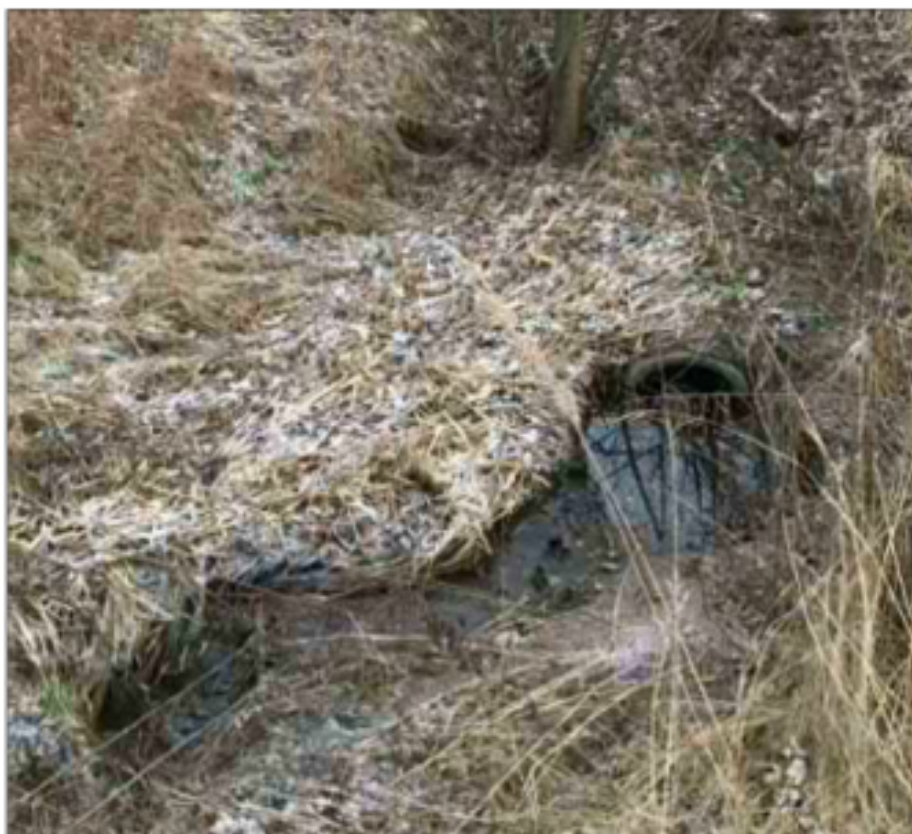
Kuva 7. Länsi Herttoniemen suunnasta tulevan hulevesiviemäriin purku ennen Viikin tien alitusta.
