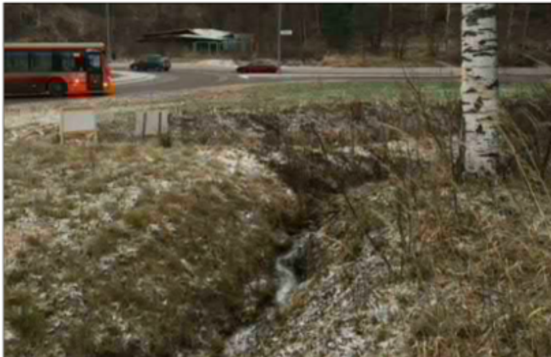
Kuva 9 Viikintien ja Viilarintien kiertoliittymän vieressä oleva painanne, josta kaava-alueen vedet siirtyvät eteenpäin tiet alittavissa viemäreissä
