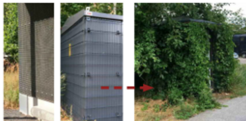
Kuva 28. Muuntaamon ilme ennen ja jälkeen kasvillisuuden kasvua
